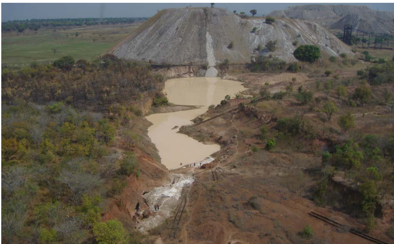
Une vue aérienne de l'ancienne ligne de chemins de fer Decauville reliant le site de Manono au port de Muyumba. La voie ferrée fut abandonnée à la fin des années 1940 au profit du transport par camions.
