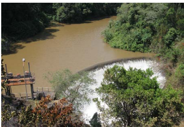
Centrale de Bendera : barrage, 2009.
