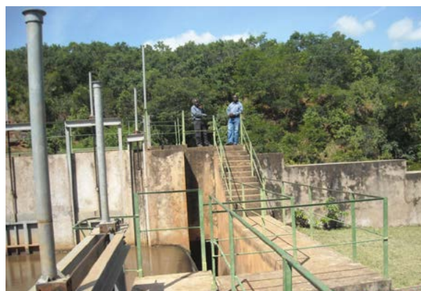
Centrale de Ngandwe Fwamba : barrage, 2011.
