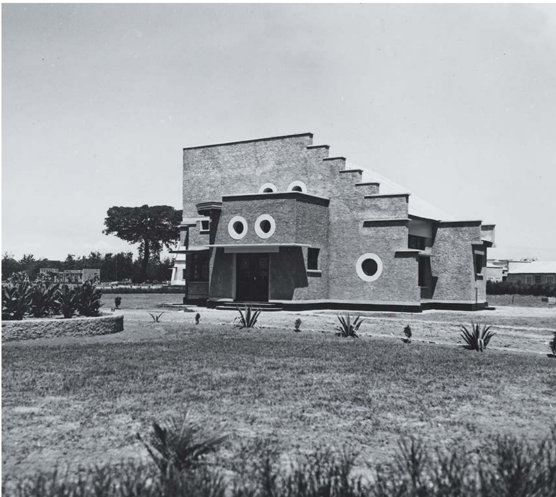
Bâtiment Art déco à Manono en 2004. (Photo © Steven Sharp, 2004.) Le même bâtiment en 1949. (HP.1956.15.4464, collection MRAC Tervuren; photo H. Goldstein © Sofam.)
