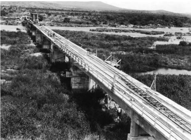
Pont de Kongolo sur le Lualaba, en construction (1938). (AP.0.2.12401, collection MRAC Tervuren; photo CFL, 1939.)
