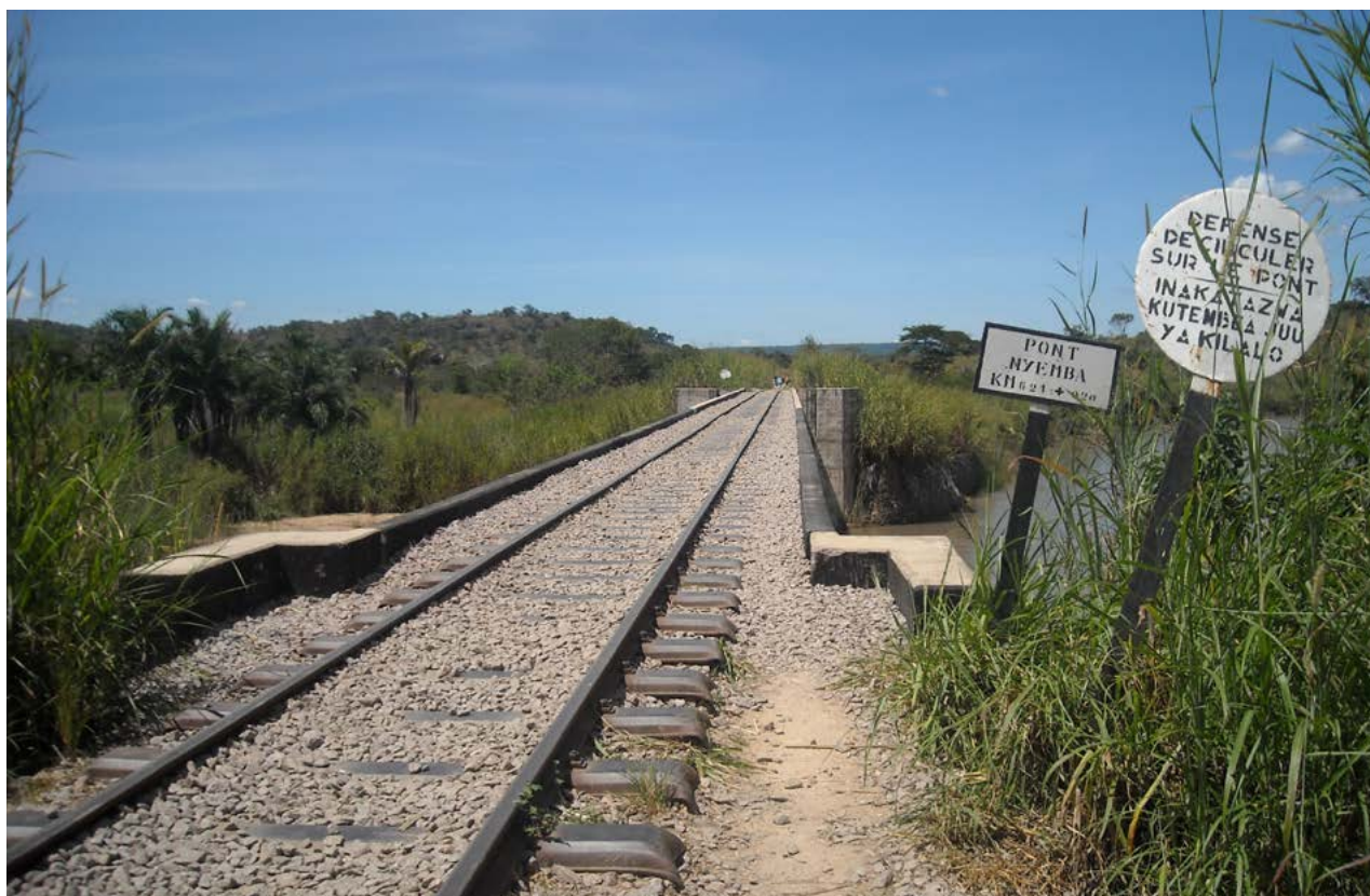
Pont Nyemba après réhabilitation.
