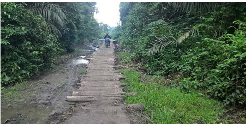
Axe Kisangani-Yangambi-Basoko. Sur les 20 derniers kilomètres avant Basoko, et avant la traversée de la rivière Aruwimi, bois empilés sur la route par les paysans pour permettre la circulation. (Photo équipe locale, 2017.)
