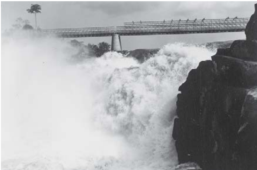
Le pont au-dessus des chutes de la rivière Tshopo à Stanleyville.
