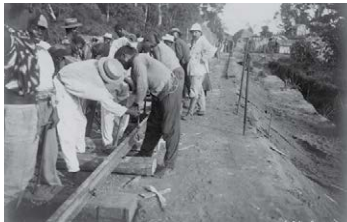
La pose du dernier kilomètre de rails du chemin de fer Stanleyville-Ponthierville. (AP.0.0.6323, collection MRAC Tervuren ; photographe non identifié, s.d. Droits réservés.)
