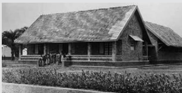
La maternité Sainte-Élisabeth à Yanonge, construite avec l'aide du Fonds du bien-être indigène. (HP.1955.96.1270, collection MRAC Tervuren ; photo C. Lamote (Inforcongo), années 1950 © MRAC Tervuren.)
