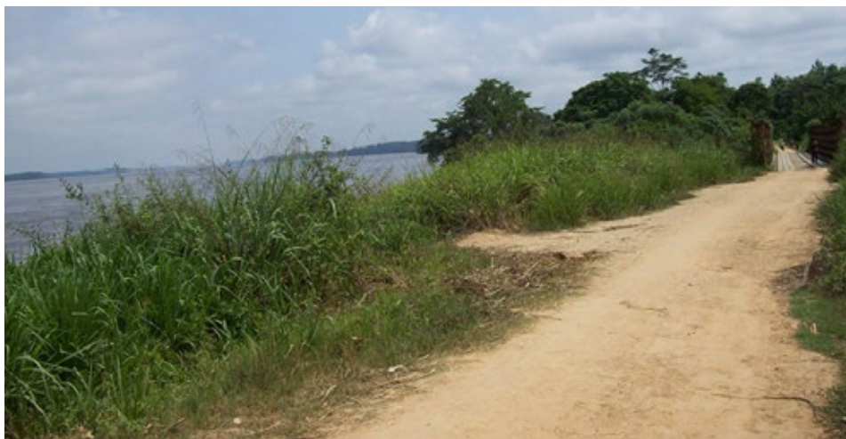
Route de Yangambi au PK 59, aperçu général.
