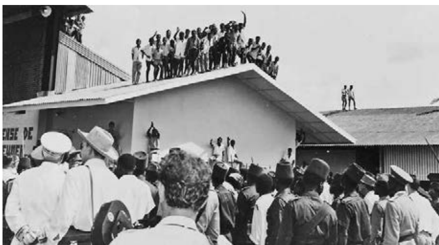
Malgré la présence des troupes de la Force publique venues sécuriser le lieu et des autorités coloniales, les Congolais montés sur les toits des installations de l'aérodrome huent les Belges et crient « Vive l'indépendance ! Vive Lumumba ! ». » (HP.1960.4.76, collection MRAC Tervuren ; photo H. Goldstein, 17 décembre 1959 © Sofam.)
