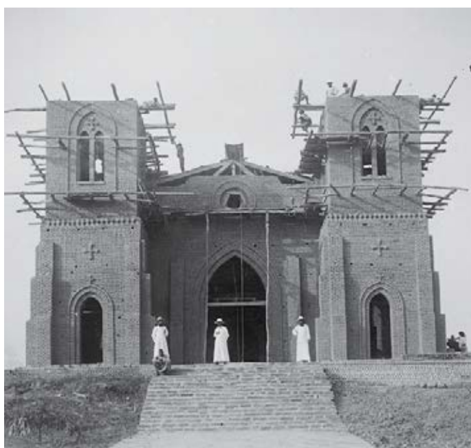
Construction de la cathédrale de Stanleyville, en 1912.
