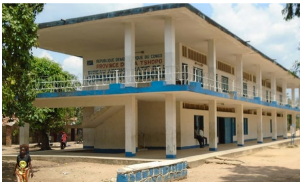
Bureau administratif de la commune de Kabondo. (Photo équipe locale/IRSA, février 2020.)
