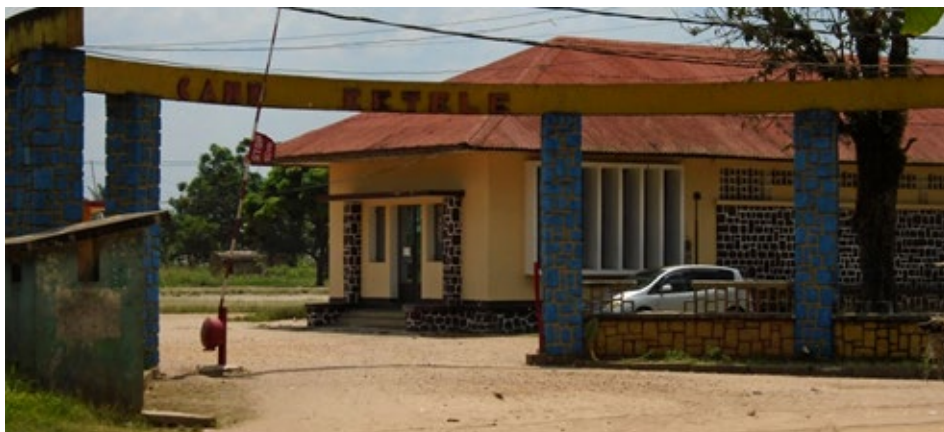
Entrée du camp Ketele à Kisangani.
