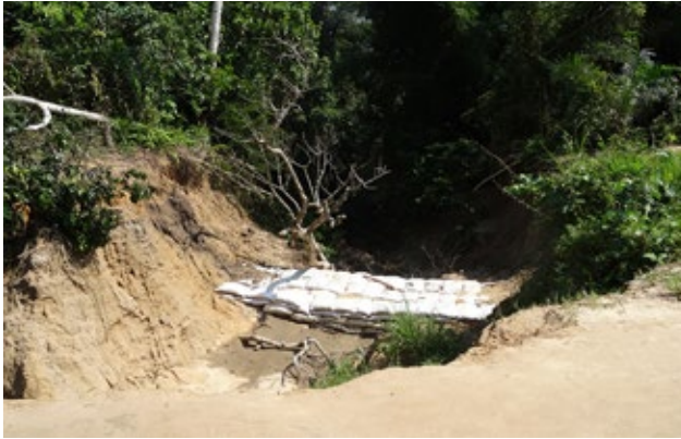
Début de réfection d'une route dégradée, sur l'axe Kisangani-Opala.
