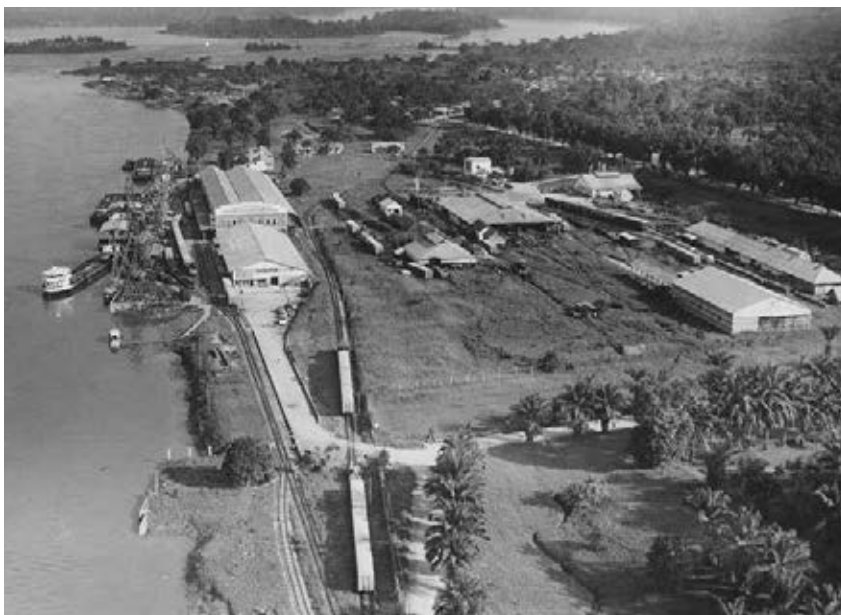
Les installations portuaires et la gare de la rive gauche du fleuve Congo à Stanleyville.
