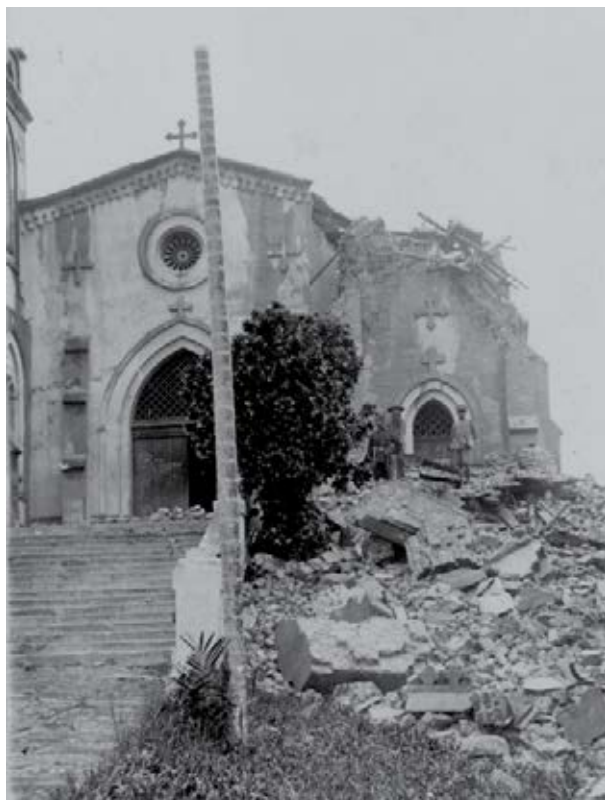
Cathédrale de Stanleyville : la tour écroulée, détruite par une tornade le 30 octobre 1930.
