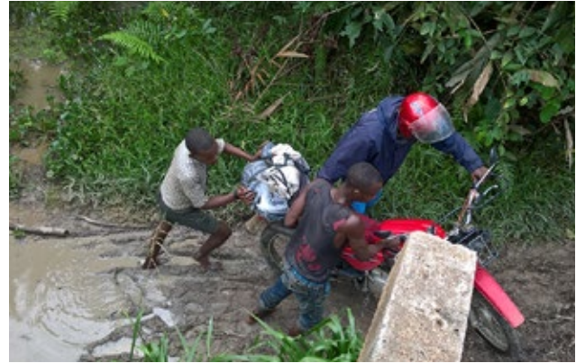
Dégradation de la route envahie par un petit cours d'eau, vers Basoko, sur les 20 derniers kilomètres.
