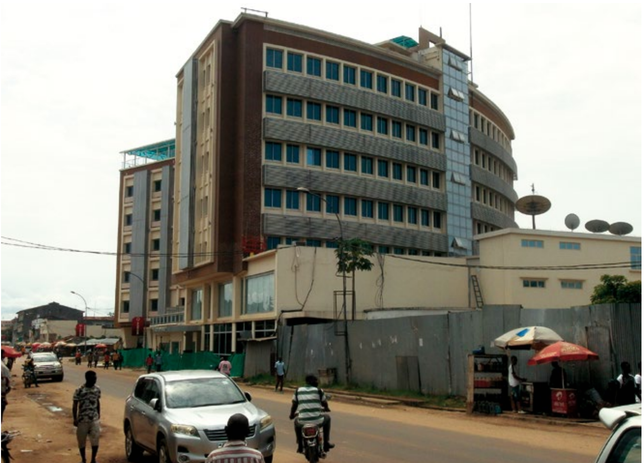
Immeuble Congo-Palace, le plus grand hôtel de Kisangani. (Photo D. Kabudri, équipe locale, 2020.)
