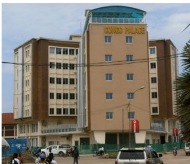
Hôtel Congo Palace à Kisangani. (Photo équipe locale/IRSA, novembre 2019.)
