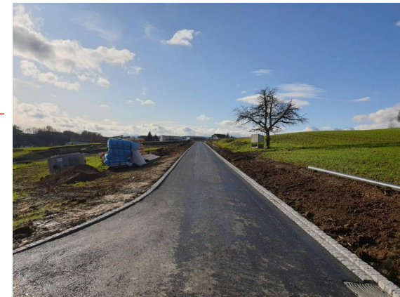
Ausgeführtes Projekt, Foto: Porta AG
