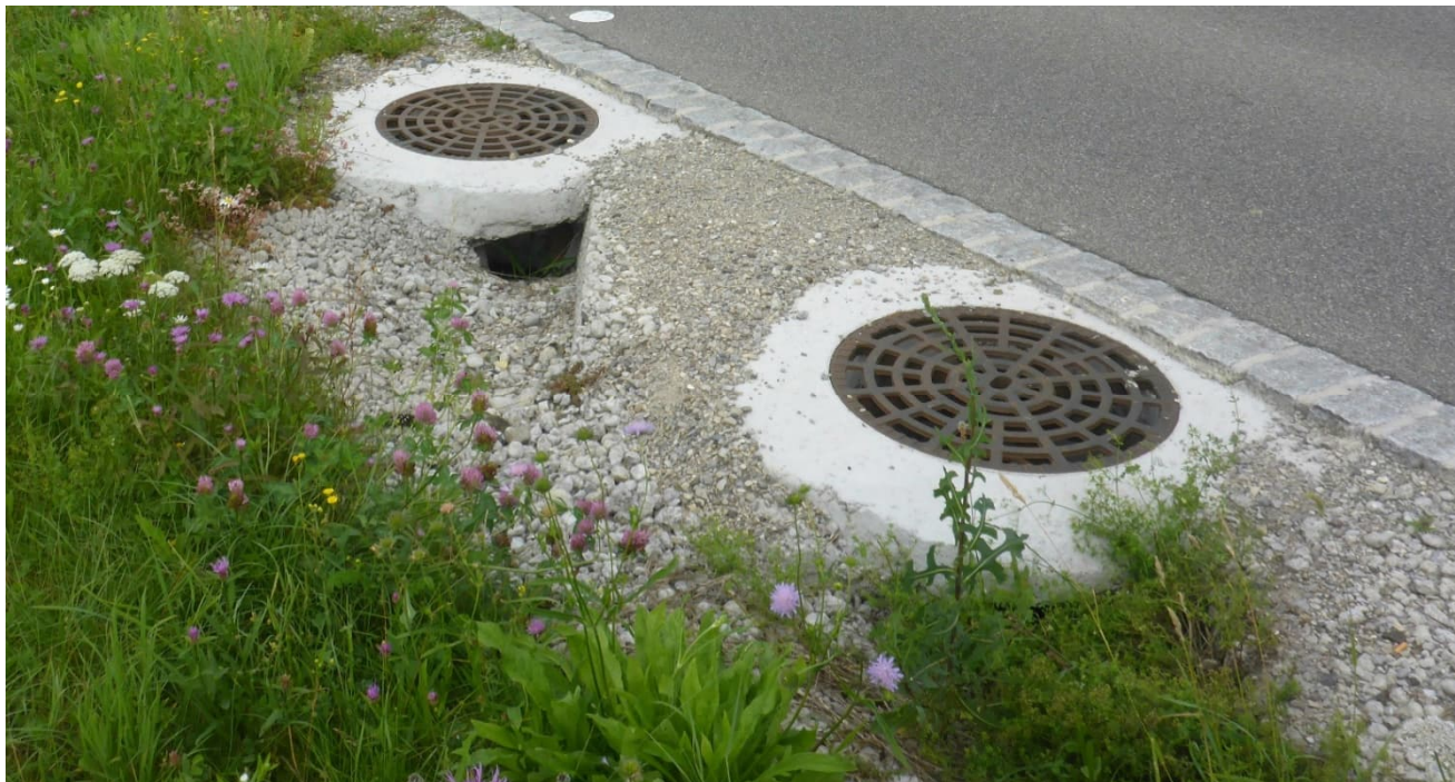
(Foto: ESP Klima – Feldentwässerung Möhlin. Kanton Aargau, 2022)
