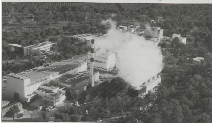
Le prototype à terre de la chaufferie du Resourtable installé au Centre d'études nucléaires de Cadarache est entré en service en 1964 : c'était le premier réacteur à eau pressurisée français. Ici, le Centre d'études nucléaires de Cadarache. CEA.
