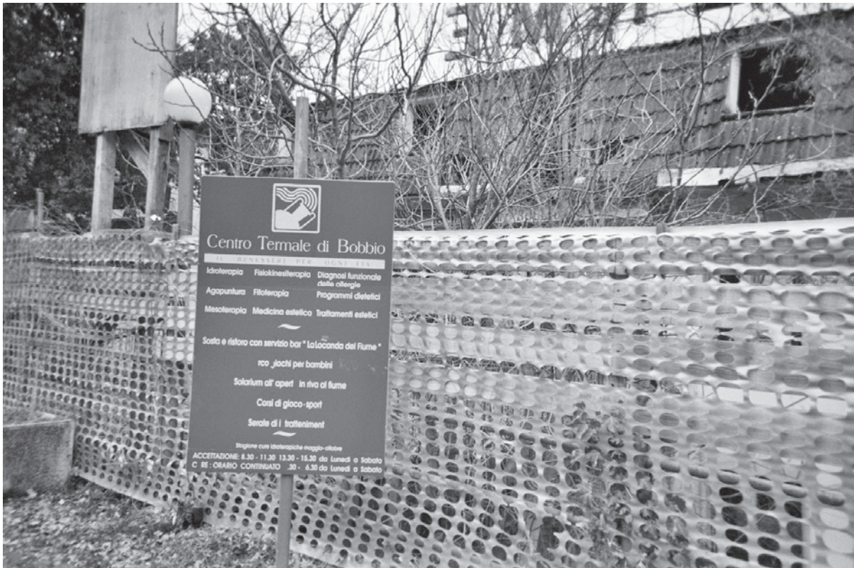
Fig. 4. L'ingresso, oggi abbandonato, al Centro Termale di Bobbio Si noti il cartello delle prestazioni erogate fino al 1999 Fonte: fotografia di Alessandro Schiavi
