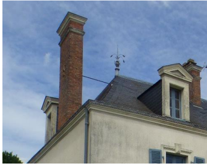
Exemple de cheminées traditionnelles en brique et massive.
