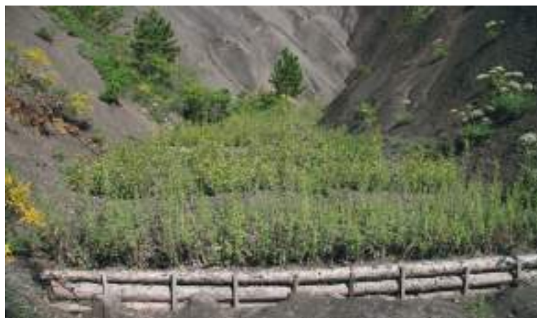
Exemple de barrière végétale installée dans une ravine pour prévenir les inondations et piéger les sédiments en amont de la rivière Durance, dans les Alpes de Haute-Provence en France.
