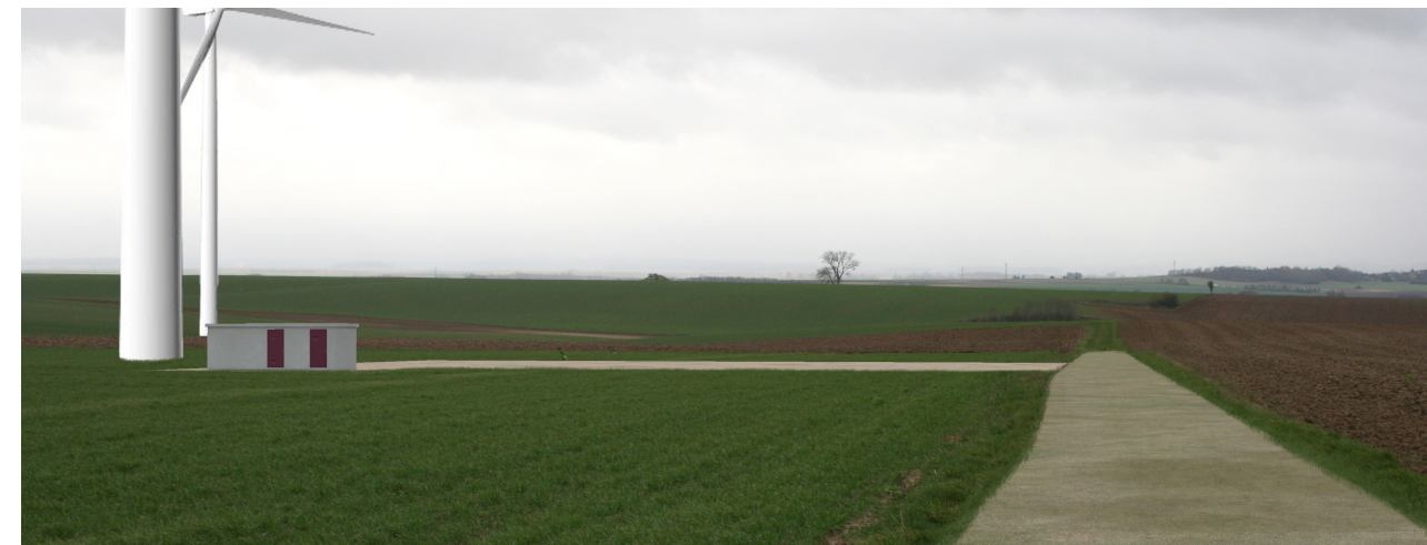
Figure 11 : Photomontage du poste de livraison n°4 envisagé pour le parc éolien des Nouvions (MO Architectes, 2016)
