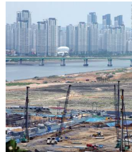
Construcción de una nueva urbanización
