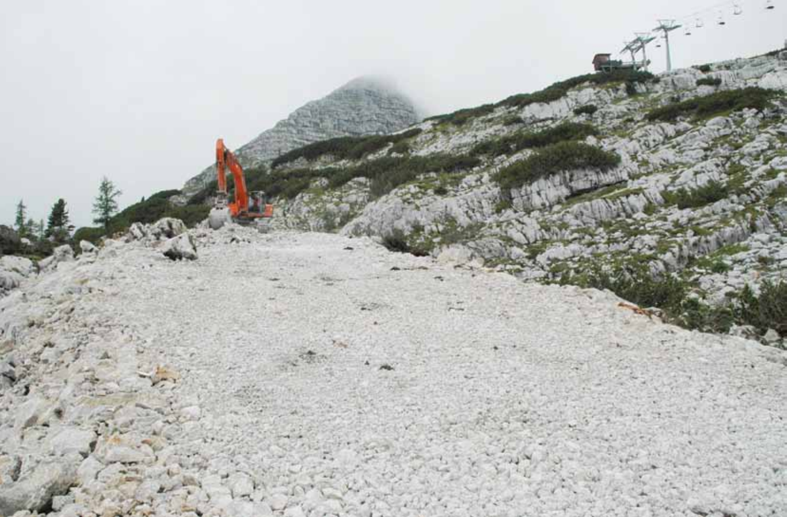
Das war hoffentlich der letzte Pistenbau im Frauenkar (Schigebiet Wurzeralm) am Rande des Naturschutzgebietes Warscheneck. Pistenbau im Karst hinterlässt besondere dauerhafte Wunden, wodurch einzigartige Karstbereiche für immer verloren gehen.
