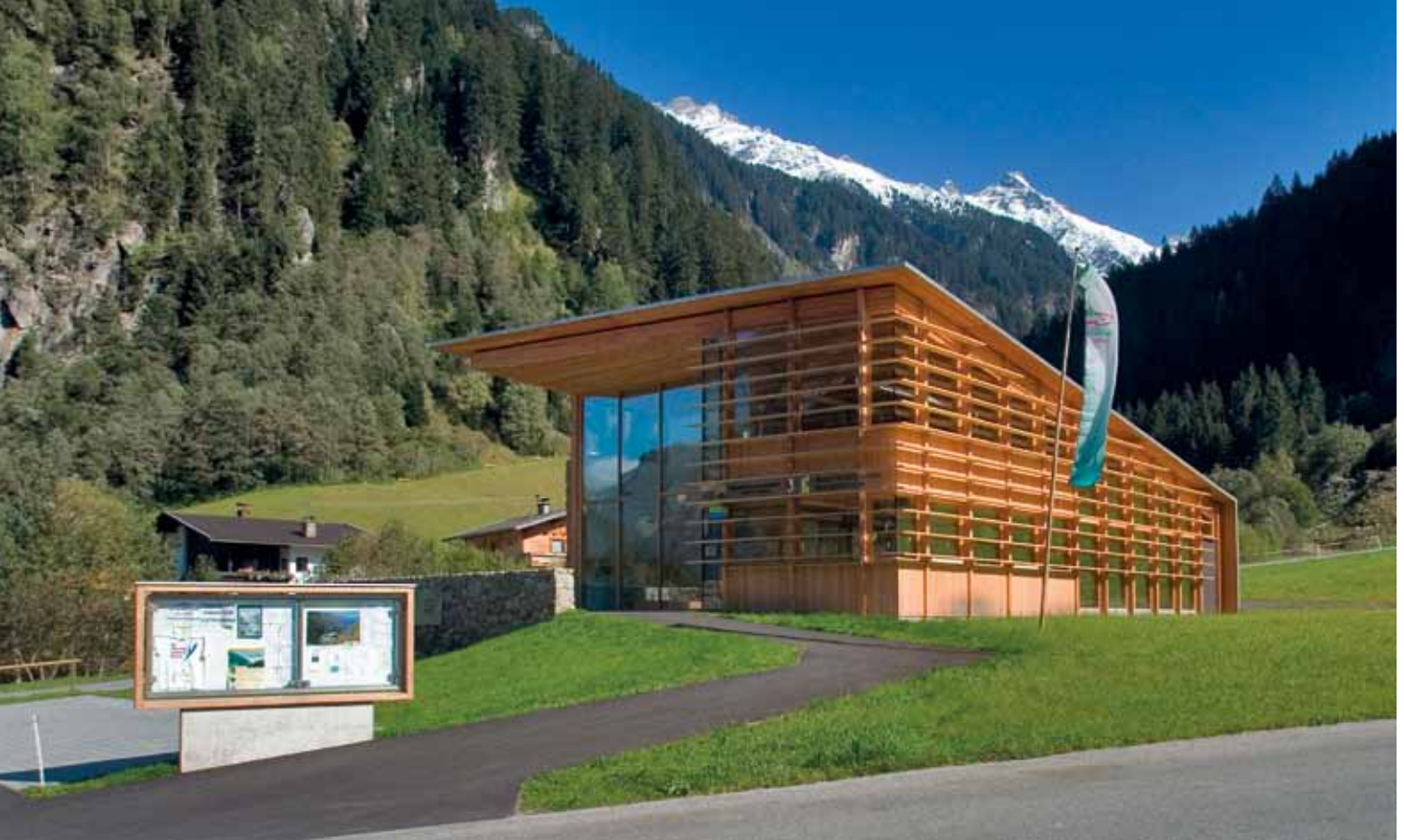
Nachhaltiges Bauen am Beispiel Naturparkhaus Zillertaler Alpen. Nullenergiehäuser sind ein möglicher Weg, um der Zukunft ökologisch zu begegnen.
