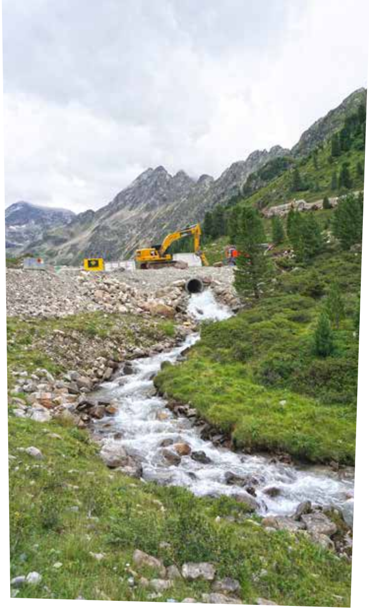
↑ Bauarbeiten im Längental. Das bisher nahezu unberührte Hochtal verschwindet hinter einer 113 Meter hohen Staumauer (August 2020).
