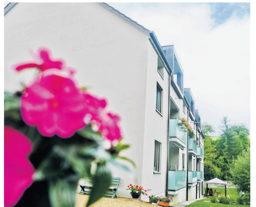
Seit rund sechs Jahren gibt es die Alterswohnungen in Diegten.
