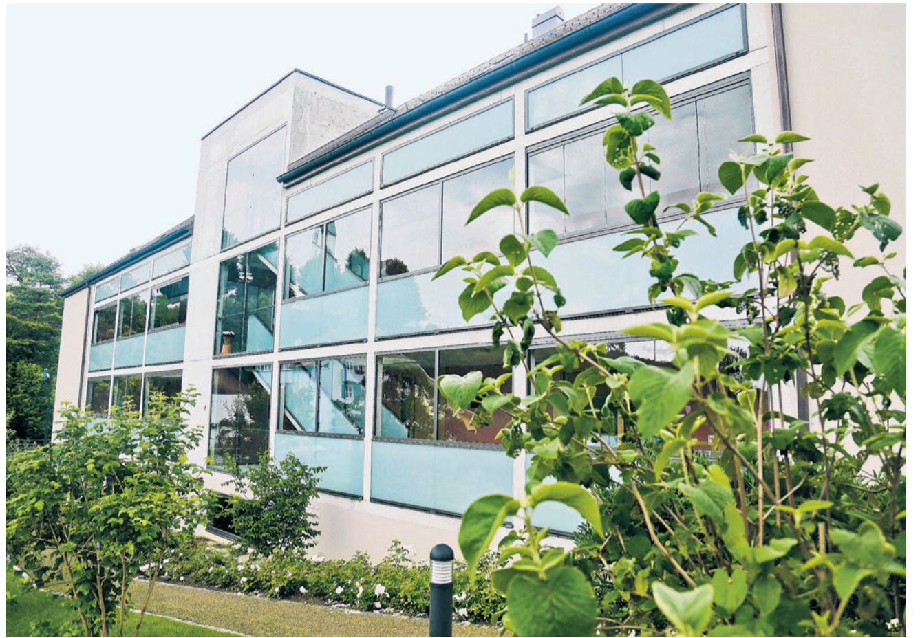
13 Wohnungen vereinen sich zu einem Mehrfamilienhaus.
