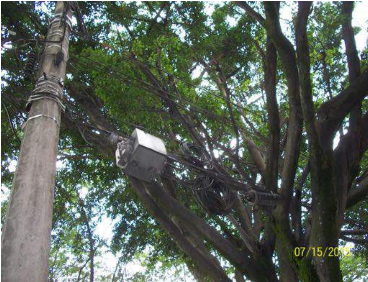
Figura 63. Conflictos entre la vegetación y los sistemas urbanos. Con infraestructura eléctrica asociada a postes.
