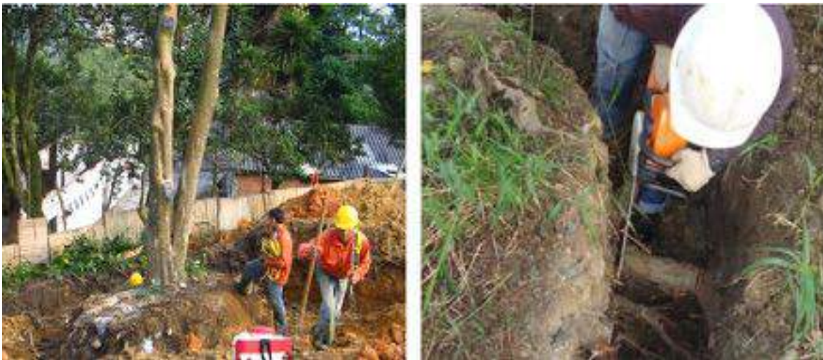
Figura 137. Izq, Corte de raíces de anclaje –motosierra-, Der, Brecha realizada para labores de prepiloneo
