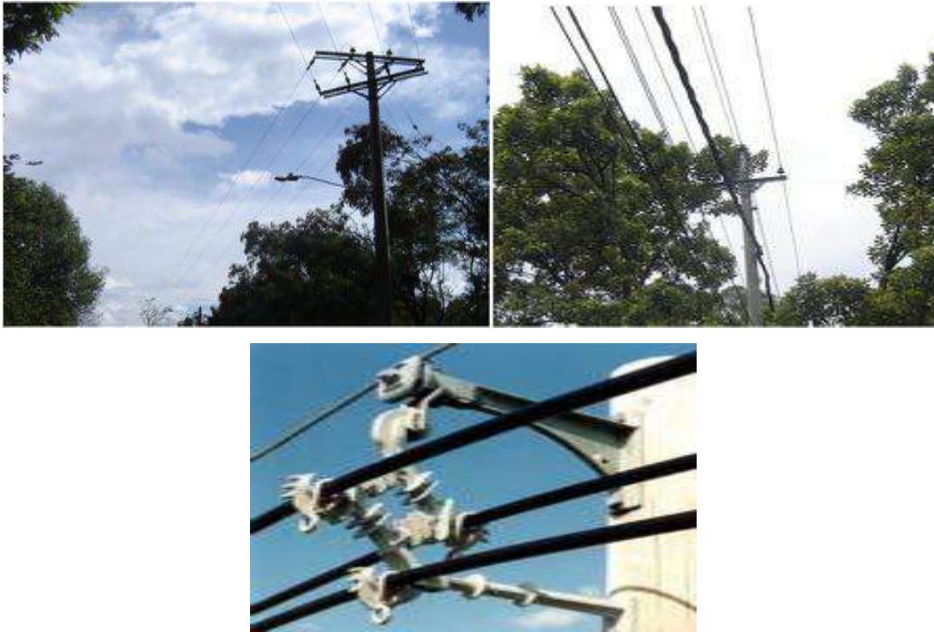
Figura 30. Red de transmisión abierta, trenzada, compacta
