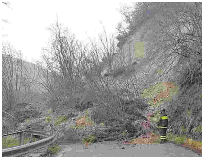
Le strade a maggior rischio frane sono quelle della Sabina e della valle del Turano
