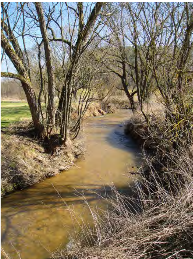
Abb. 4: Mühlbach der Heinzenmühle mit der vom WWA Ansbach künstlich eingebrachten Kiessohle im Jahr 2012.
