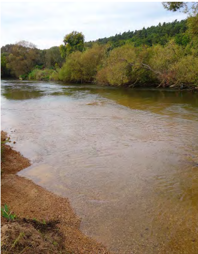
Abb. 13: Die größte Kiesmenge, die im LIFE+-Projekt eingesetzt wurde. Der neue Kieselkörper erzeugt verschiedene Teilströmungen und eine geringere Flusstiefe in der Rednitz.
