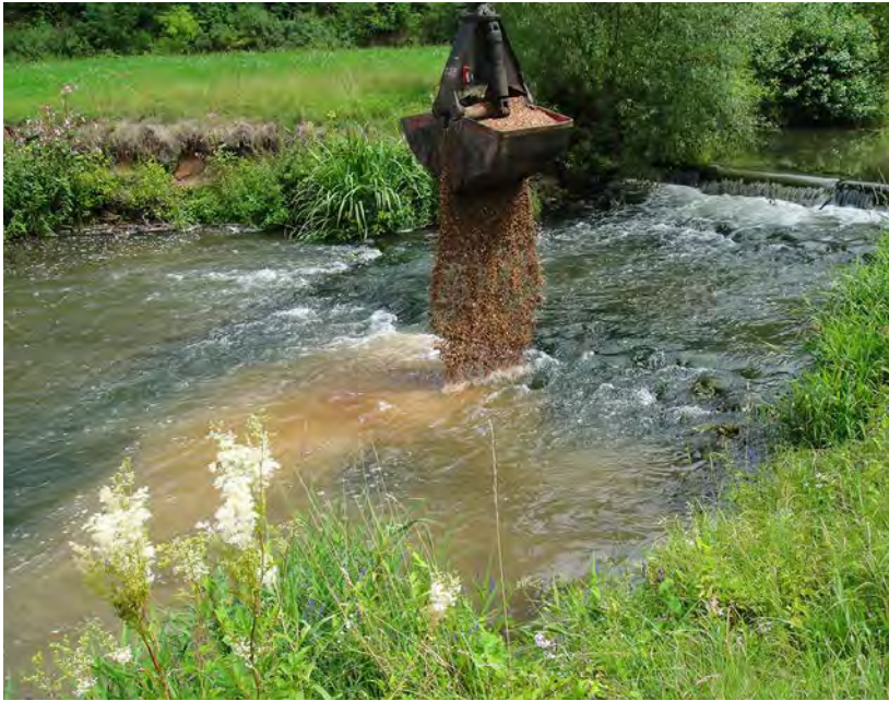
Abb. 6: Einkippen von Kies unterhalb eines Sohlabsturzes in die Schwäbische Rezat mit Hilfe eines Baggers.
