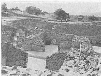
Fig. 3. Vista general del edificio donde se aprecia la situación interior del sumidero.
