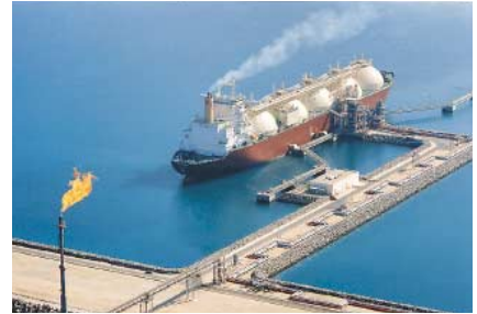
QATARGAS LNG project in Qatar
