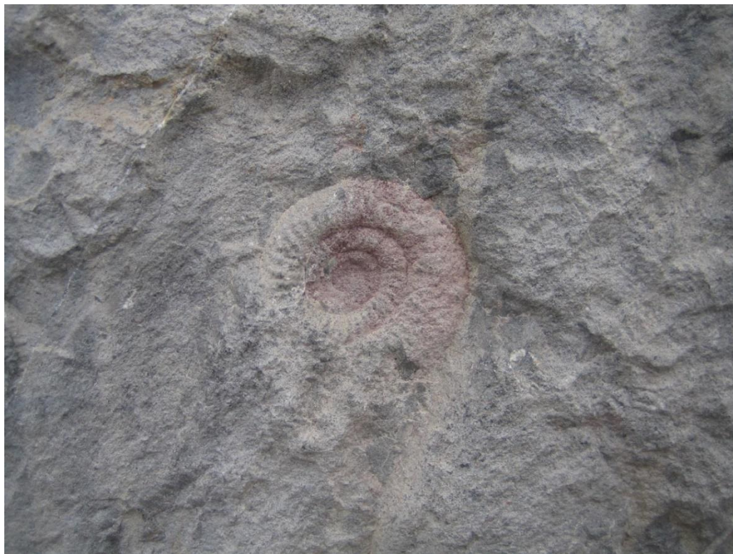
Figura 4. Piedra de Calatorao con ammonites en una fachada de Zaragoza
