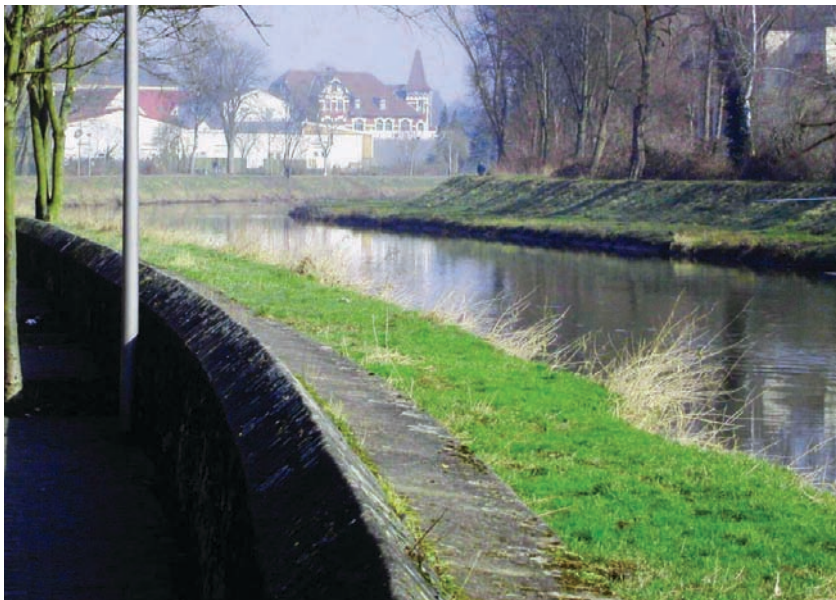
Abb. 3.1.5-1 Else in Bünde mit Hochwasserschutz- mauer
