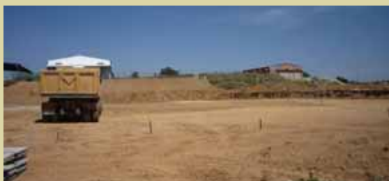
Aspecto da terraplanagem para a nova Clínica de Portalegre
