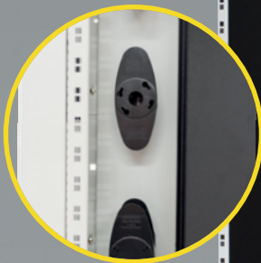
Radienbegrenzer zum Kabelmanagement innerhalb der vertikalen Kabelkanäle
