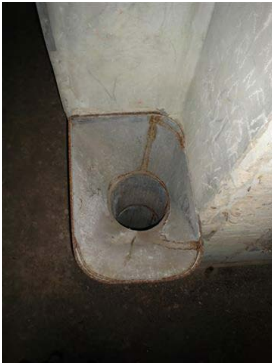
Foto. Hulzentrechtters in de bunkers zijn 'death-traps' voor vleermuizen foto Bob Vandendriessche
