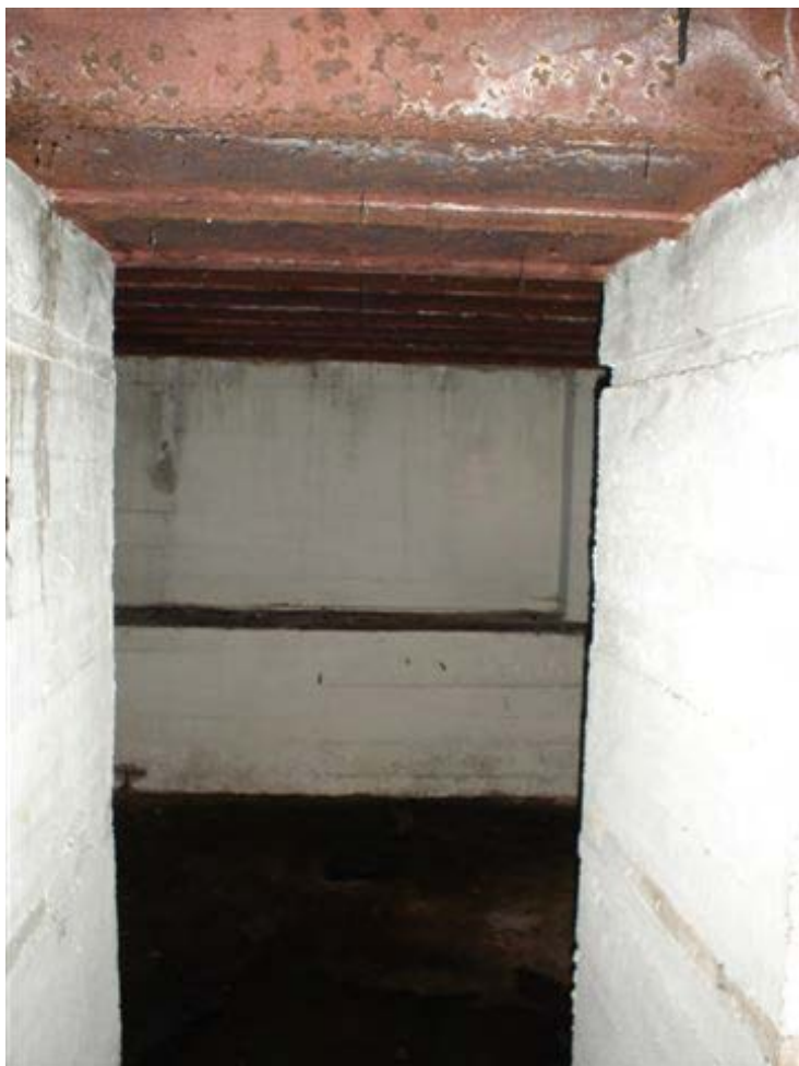
Foto. Een extra deur in dit deurgat kan in de achterliggende kamer een stabiel binnenklimaat met hoge luchtvochtigheid creëren
