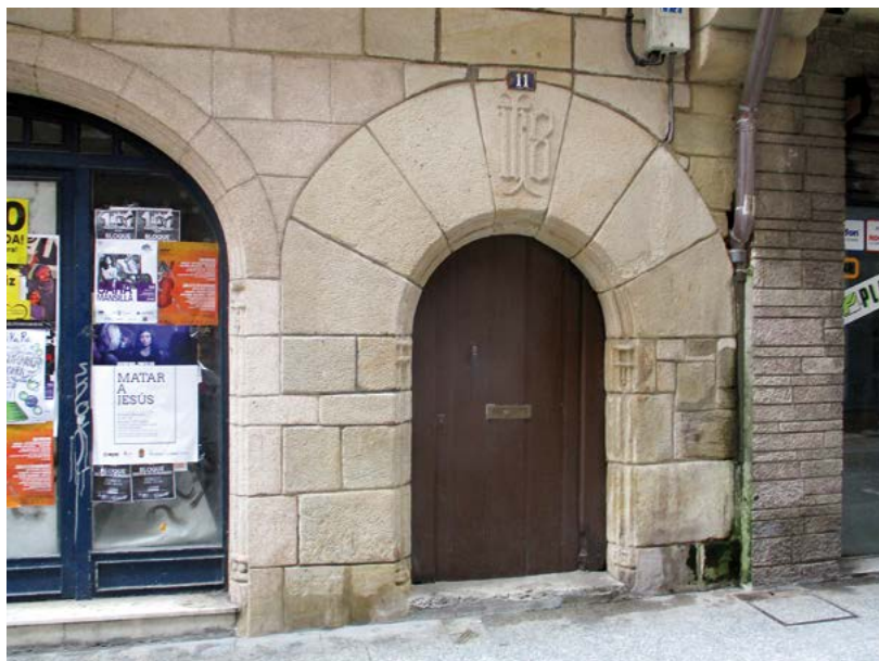
Detalle de la fachada principal del solar de Erdikokale 11 (Erreenteria) con un arco de medio punto dovelado con una inscripción con letras góticas en relieve. © A. MORAZA
