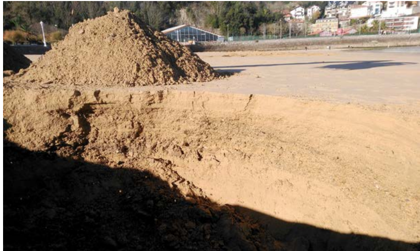
Figura 2. Monocapa de escombros (arena-escombros-arena), y debajo más arena limpia.
