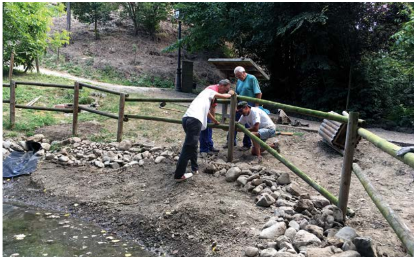
Reparación de la charca de la Fuente de Chapas. ION GARIN BARRIO
