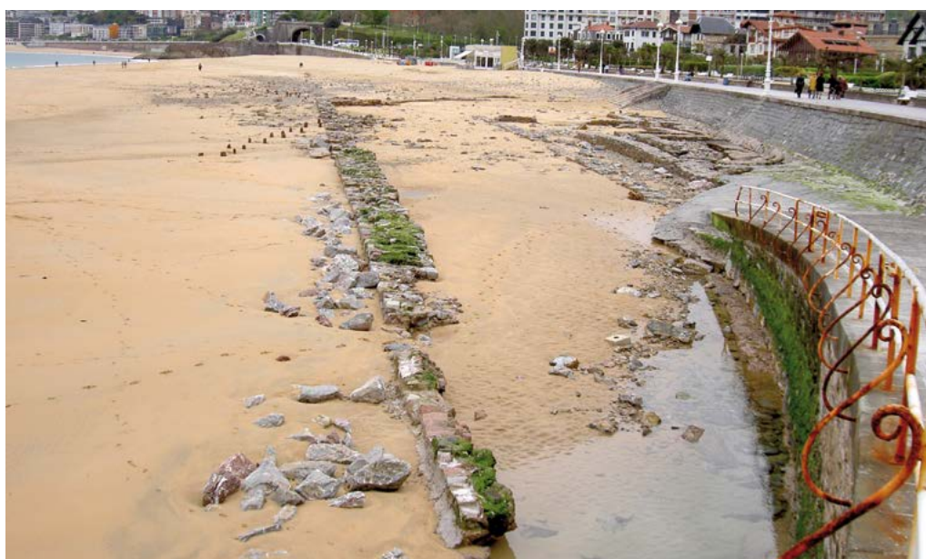
Figura 5. Detalle de las estructuras de la antigua cárcel y de los cascotes que retenía.
