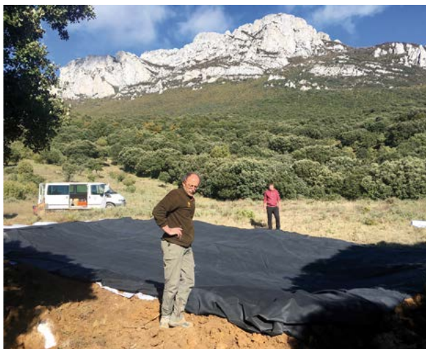
Aranzadiko langile eta laguntzaileek Laguardian sortutako putzuetako bat iragazgaizteko kautxu geruza ezartzen. © I. GARIN-BARRIO
