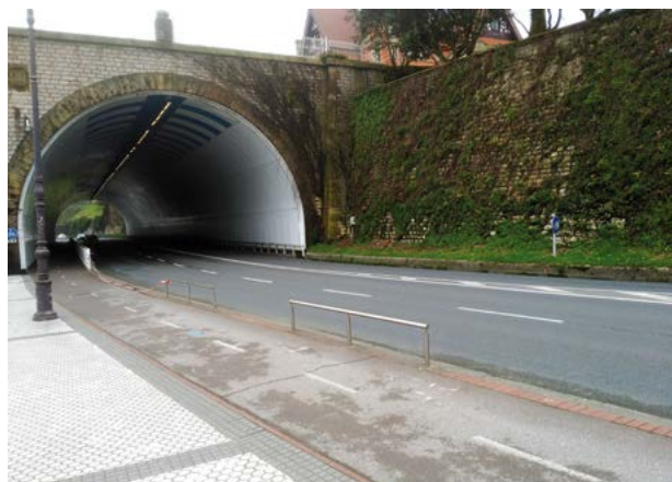
Figura 21. Túnel del Antiguo y ladera del parque de Miramar.
