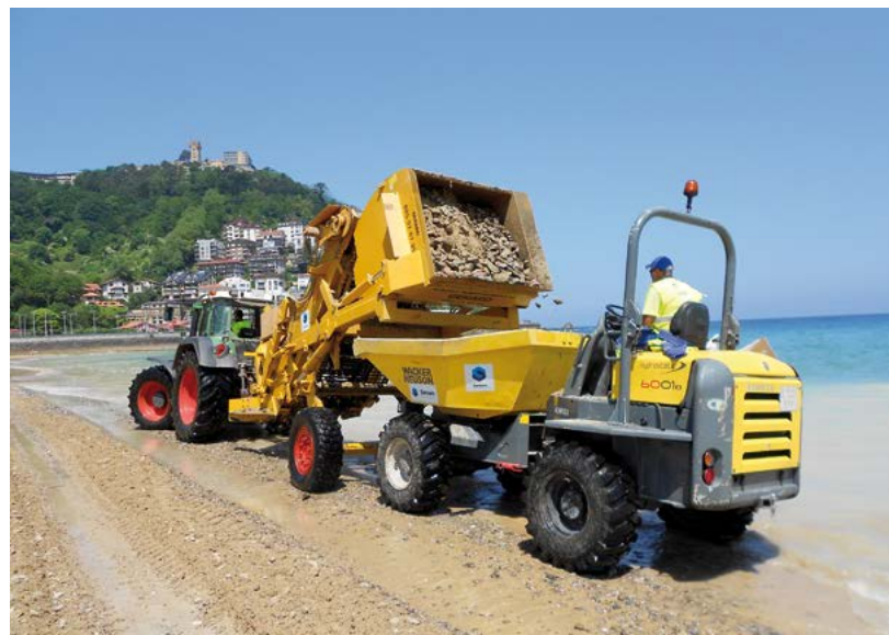
Figura 31. Proceso de retirada de cascotes.
