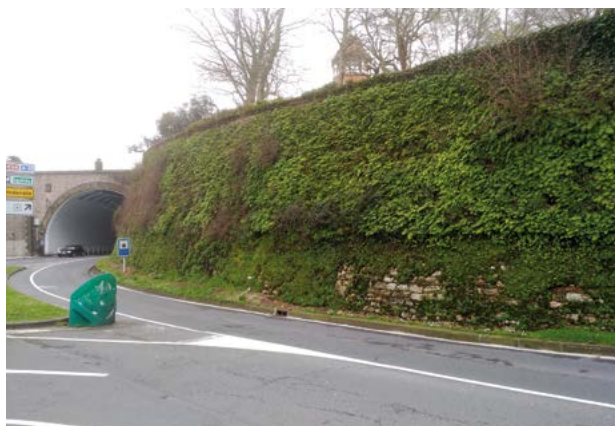
Figura 18. Ladera de Miramar con el muro de contención.
