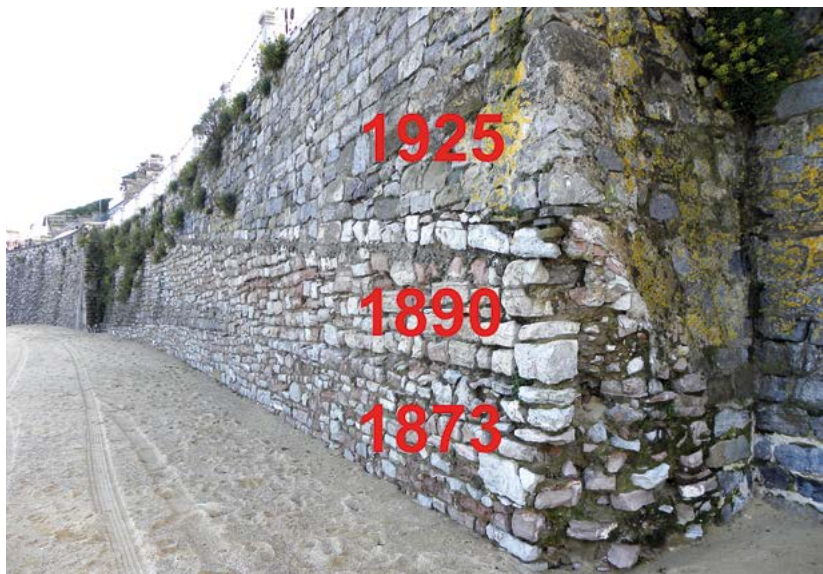
Figura 4. Muro de costa del antiguo campo de maniobras (1873), levante del muro tras la construcción del túnel del Antiguo (1890) y el muro de los jardines de Ondarreta (1925).
