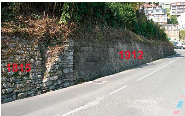
Figura 24. Muro de mampostería caliza (1815) y muro de bloques "sillares" de piedra de arenisca (1912).
