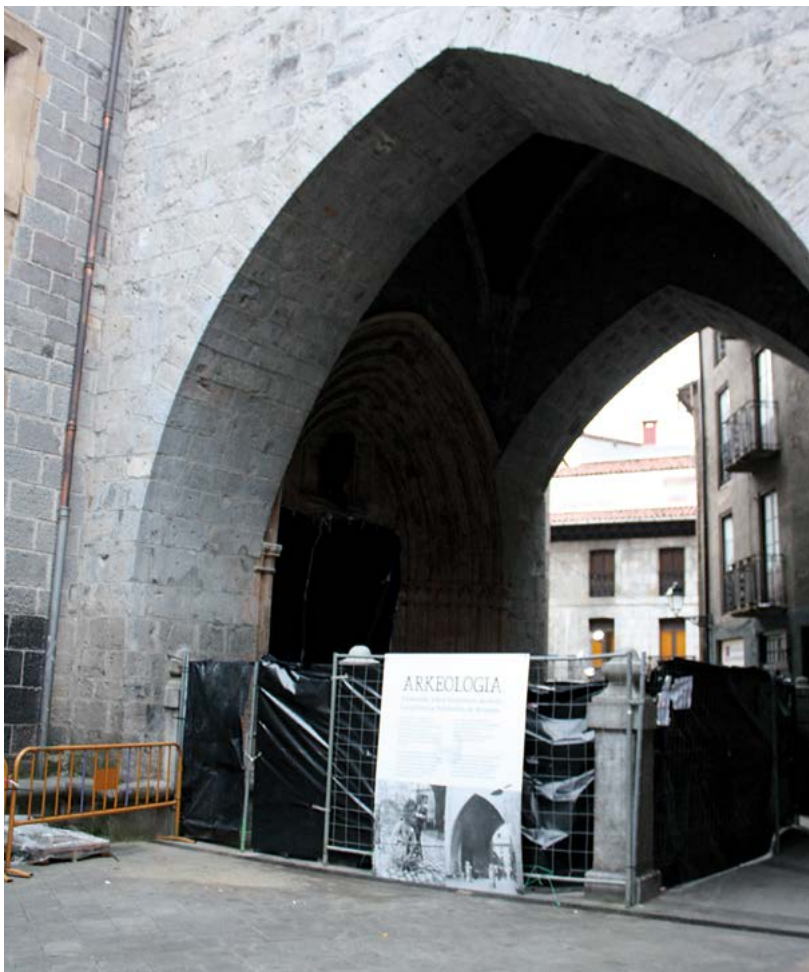
Localización del área de trabajo en la Torre del Campanario o Kanpandorrea (Arrasate).
