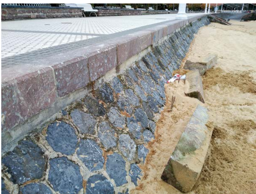
Figura 27. Muro de Costa construido en 1925.
