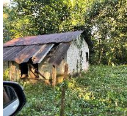
Photo 10 Vi viendas de guardianes finca "Río Frío".
