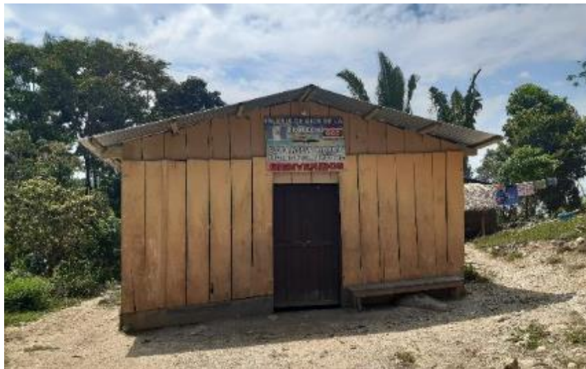
Figure 37. Evangelical Church in Nuevo Río Frío. Photograph: Andrés Álvarez.
