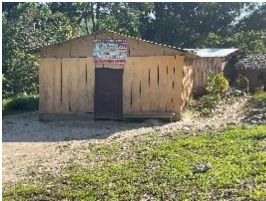
Photograph 27. Nuevo Río Frío Community Church.
