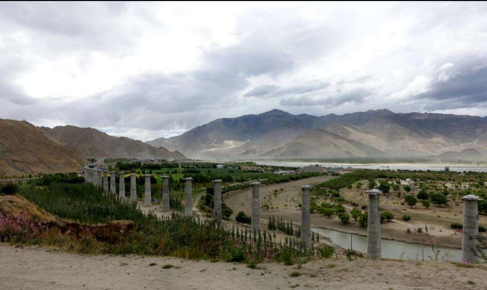
Vallée du Yarlung Tsangpo (Yalun Zangbu) : région de Tsethang (Zedang), infrastructure autoroutière en construction
