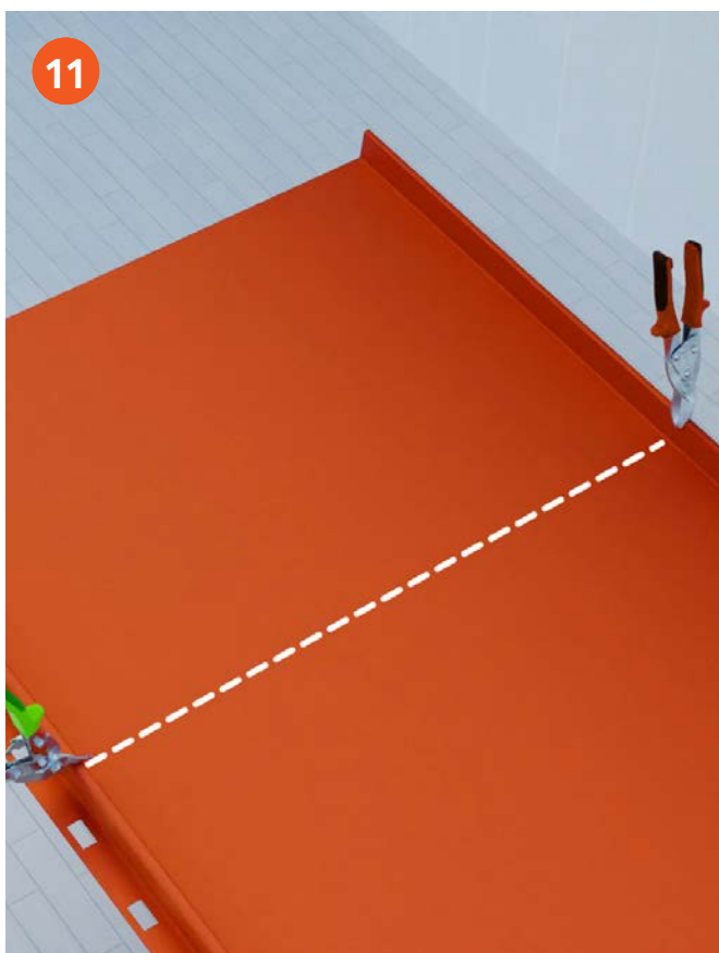
Klipp upp falsarna med hjälp av vänster och höger plåtsax.
