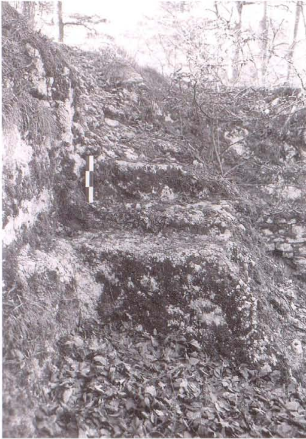
Abb. 5 Ansichten der Treppe von SE.
