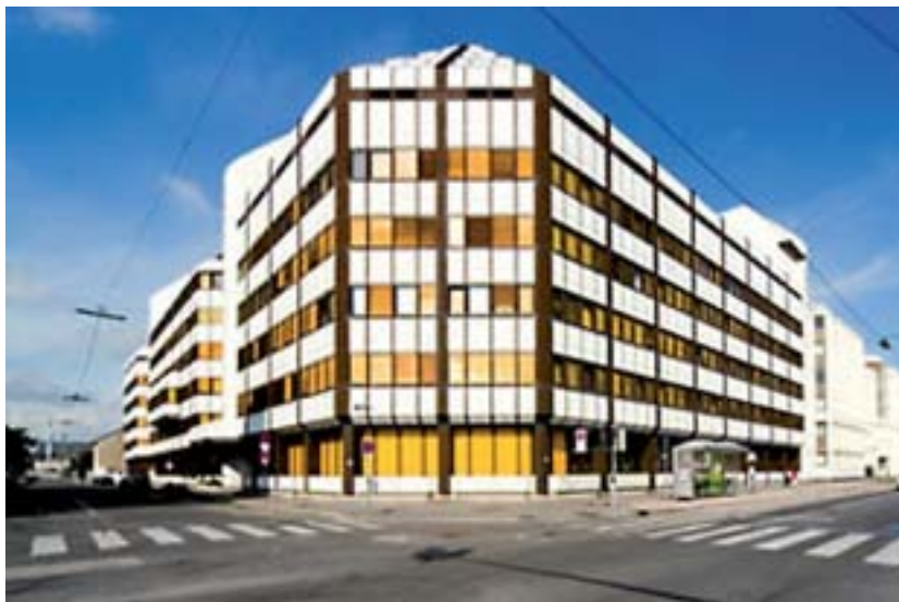
Budynek Austriackiego Archiwum Państwowego w Wiedniu przy ulicy Nottendorfer Gasse 2–4 (źródło: <oesta.gv.at>)
