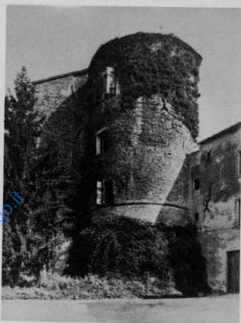
MONTELEONE: la torre del castello
