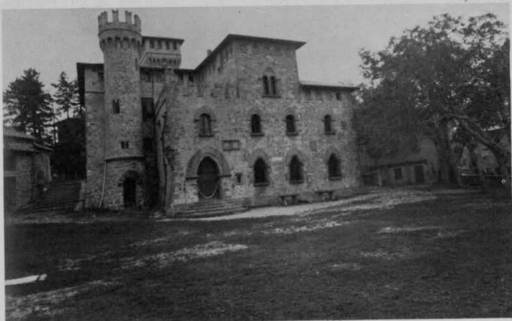
CASTELLUCCIO: la facciata del castello Manservisi
