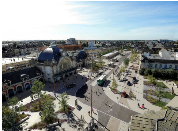
Abbildung 46: Neuer Vorplatz Norden Bahnhof Saint-Brieuc, Quelle: www.banquedesterritoires.fr
