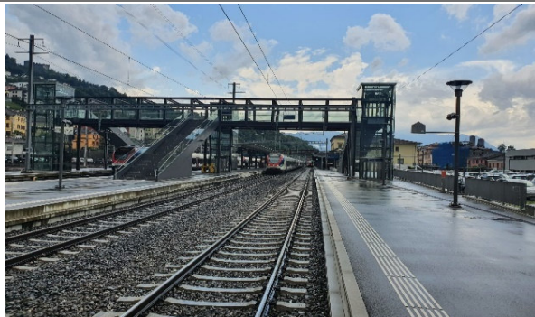
Abbildung 10: Neuer Fussgängerübergang im Norden des Bahnhofs von Bellinzona, Quelle: eigene Aufnahme
