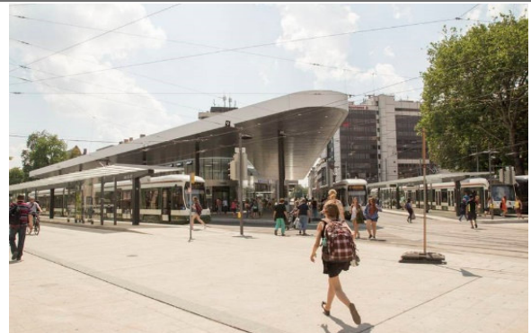
Abbildung 43: Umsteige-Dreieck Königsplatz in Augsburg, Quelle: www.projekt-augsburg-city.de > Neue Innenstadt > Fertige Innenstadt > Rundgang 1
