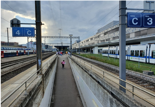
Abbildung 18: Bahnhof Wallisellen, Quelle: eigene Aufnahme
