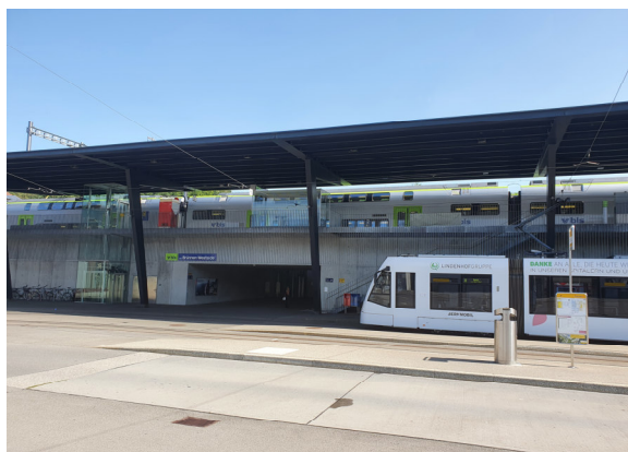
Abbildung 15: Bahnhof Bern-Brünnen, Quelle: eigene Aufnahme
