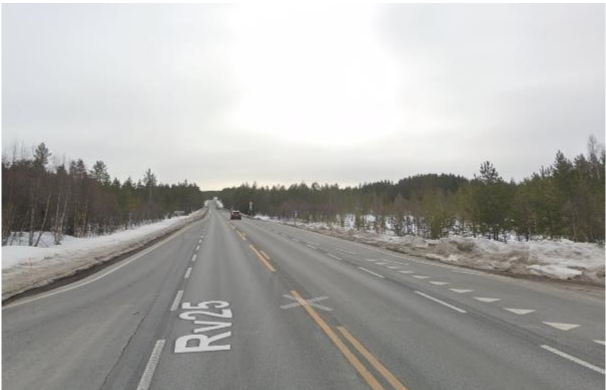
Figur 20 Sikt fra krysset mot øst
