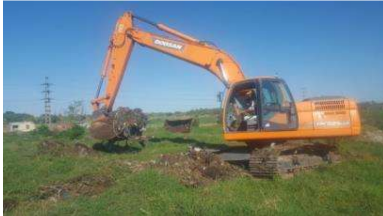
Foto 8-3 Momento de la remoción del suelo para efectuar las calicatas
