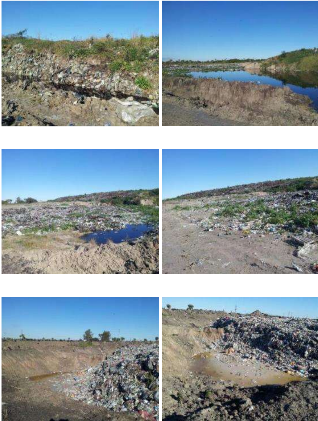
Figura 7-7. Fotografías del predio de disposición final de residuos (actual BCA), ciudad de Formosa.
