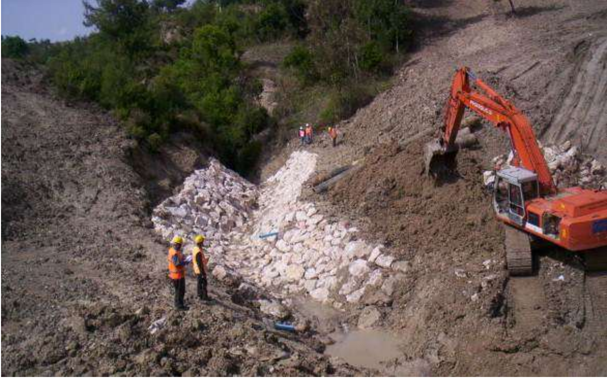
Şekil III.2.19.115. Dere Yataklarında Rip-Rap Onarım Çalışması, Fotoğraf: B. ERDEM, 2006
