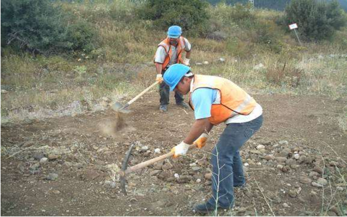
Şekil III.2.19.109. Minör Oturmaların Meydana Geldiği Bir Alanda Gerçekleştirilen Tesviye Çalışmaları Fotoğraf: B. ERDEM, 2006
