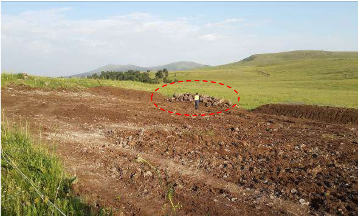
Şekil III.2.19.62. Taşlık Alanlarda Üst Toprak Sıyırma Çalışmaları, Fotoğraflar: B. ERDEM, 2015
