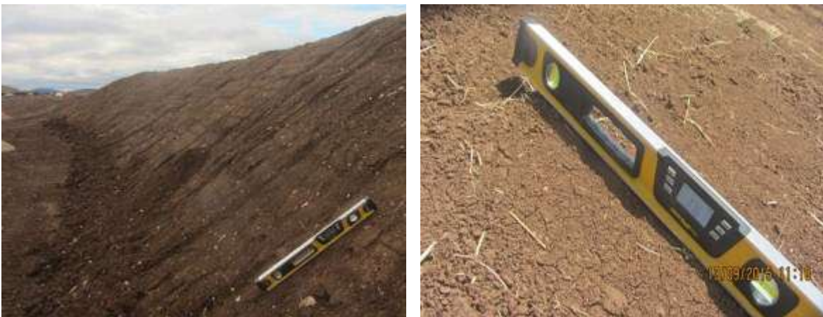
Şekil III.2.19.67. Üst Toprak Depolama Alanlarında Şev Açısının ve Yiğınların Yüksekliğinin Ölçüm Yoluyla Kontrol Edilmesi, Fotoğraflar: B. ERDEM, 2015
