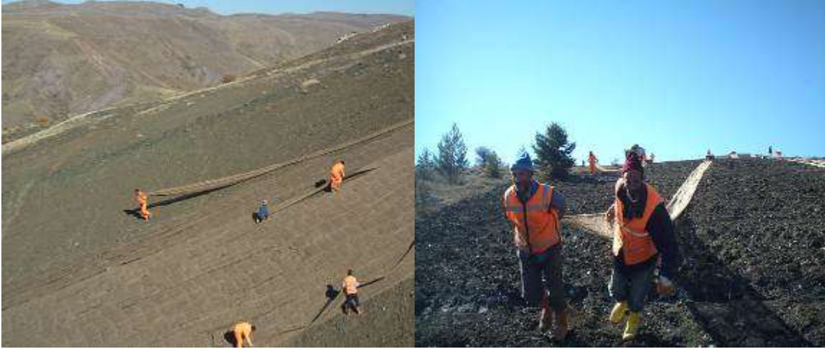
Şekil III.2.19.84. Açılan Jüt Hasır Balyalarının Şeritler Halinde Yüze Serilmesi, Fotoğraflar: B. ERDEM, 2006
