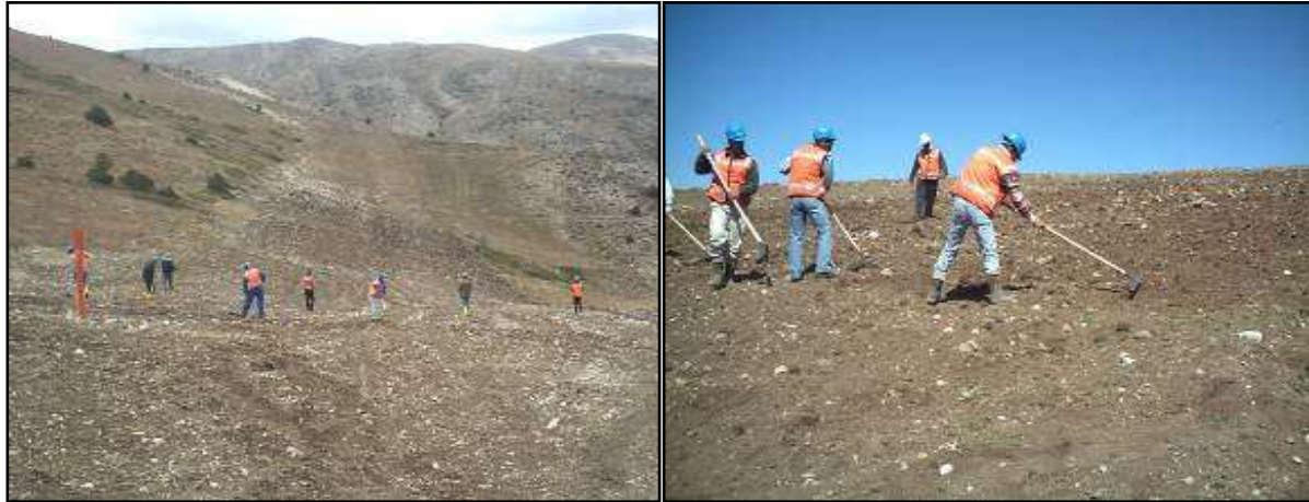
Şekil III.2.19.100. Tohumlama Öncesinde Gerçekleştirilen Tırmıklama Çalışmaları, Fotoğraflar: B. ERDEM, 2005
