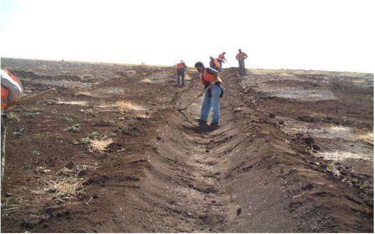
Şekil III.2.19.113. Açılan Eğim Kırıcılarında Sediment Temizlik Çalışması, Fotoğraf: B. ERDEM, 2006
