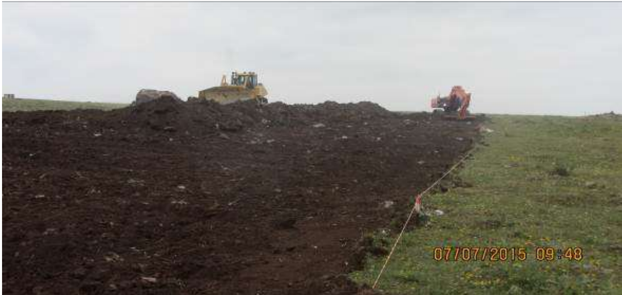
Şekil III.2.19.61. (devamı) İnşaat Döneminde Bitkisel (Üst) Toprağın Sıyırılması Çalışmaları, Fotoğraflar: B. ERDEM, 2005 / 2015
