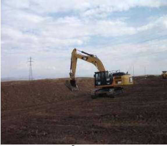
Şekil III.2.19.68. Üst Toprak Depolama Alanlarında, Yığınların Sıkıştırılması Çalışmaları, Fotoğraflar: B. ERDEM, 2015
