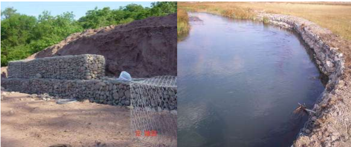
Şekil III.2.19.92. Kalıcı Erozyon Kontrol Önlemleri, Gabion Duvarlar, Fotoğraflar: B. ERDEM, 2005 / 2007
