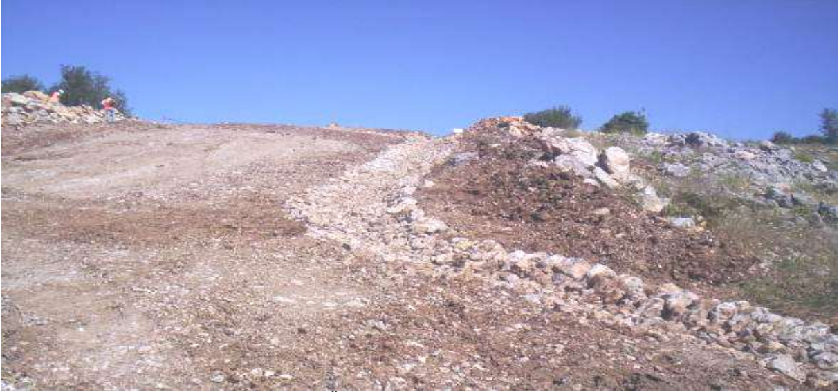
Şekil III.2.19.88. Kalıcı Erozyon Kontrol Önlemleri, Çevirme Kanalları, Fotoğraf: B. ERDEM, 2004
