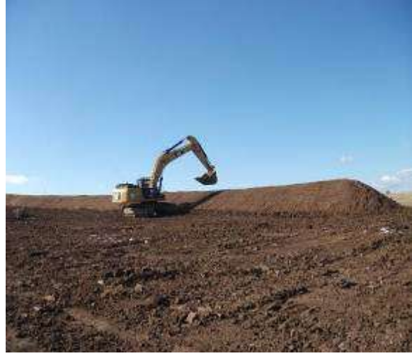
Şekil III.2.19.68. Üst Toprak Depolama Alanlarında, Yığınların Sıkıştırılması Çalışmaları, Fotoğraflar: B. ERDEM, 2015
