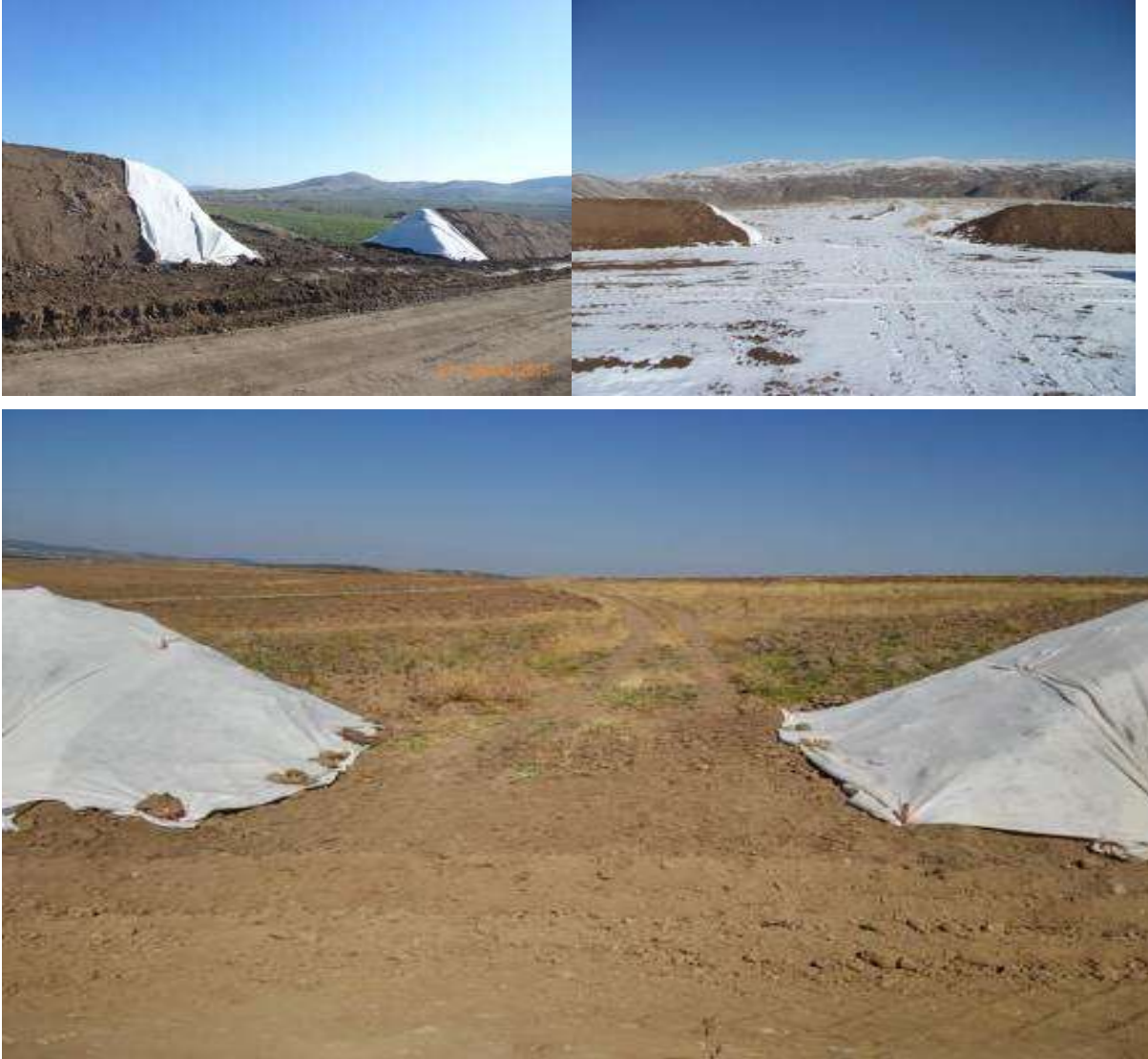
Şekil III.2.19.66. Üst Toprak Depolama Alanlarında, Yiğınlar Arasında Bırakılan Açıklıklar, Fotoğraflar: B. ERDEM, 2015
