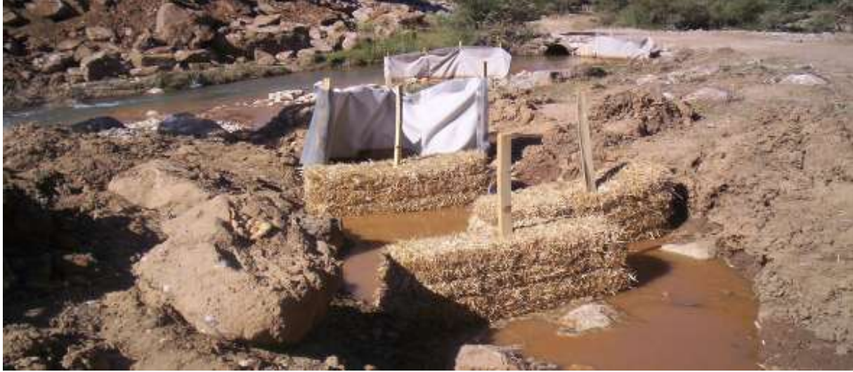
Şekil III.2.19.75. Sedimentasyon Kontrolünde Saman Balyası Uygulaması, Fotoğraf: B. ERDEM, 2005
