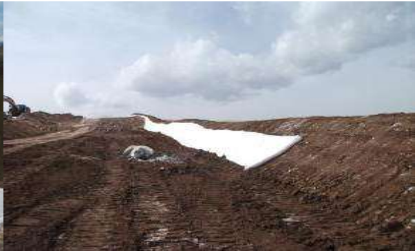
Şekil III.2.19.71. a, b ve c- Dikine ve Enine Eğimlerde Açılan Drenaj Kanalları, Eğim Kırıcılar, Fotoğraflar: B. ERDEM, 2006
