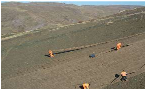
Şekil III.2.19.72. Erozyon Şiltesi ve Jüt Hasırı Uygulaması Fotoğraflar: B. ERDEM, 2006
