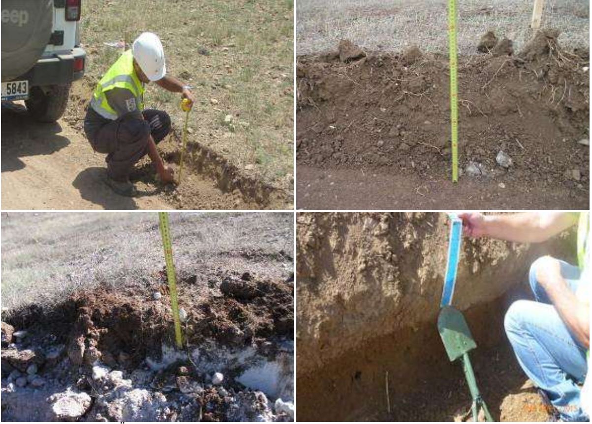
Şekil III.2.19.59. Üst Toprak Sıyırma Çalışmaları, Sıyırma Derinliği Kontrolü, Fotoğraflar: B. ERDEM, 2015
