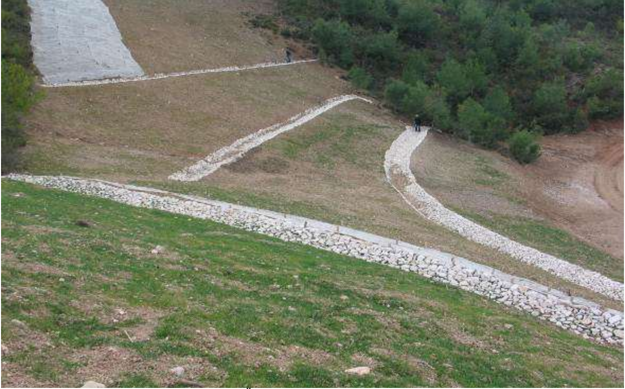
Şekil III.2.19.81. Kalıcı Erozyon Kontrol Önlemleri, Eğim Kırıcılar, Fotoğraf: B. ERDEM, 2005
