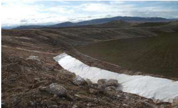
Şekil III.2.19.71. a, b ve c- Dikine ve Enine Eğimlerde Açılan Drenaj Kanalları, Eğim Kırıcılar, Fotoğraflar: B. ERDEM, 2006
