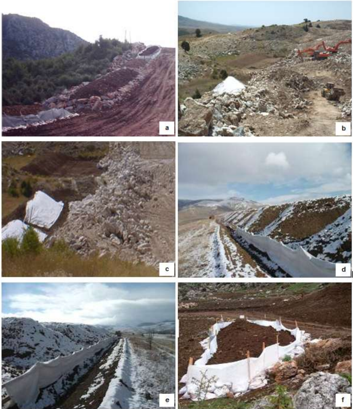
Şekil III.2.19.63. Üst Toprak Depolama Yöntemleri Kapsamında; a- Taş Tahkimat, b, c- Geotekstil Kaplama ve d, e, f- Silt Kafes Uygulamaları, Fotoğraflar: B. ERDEM, 2006
