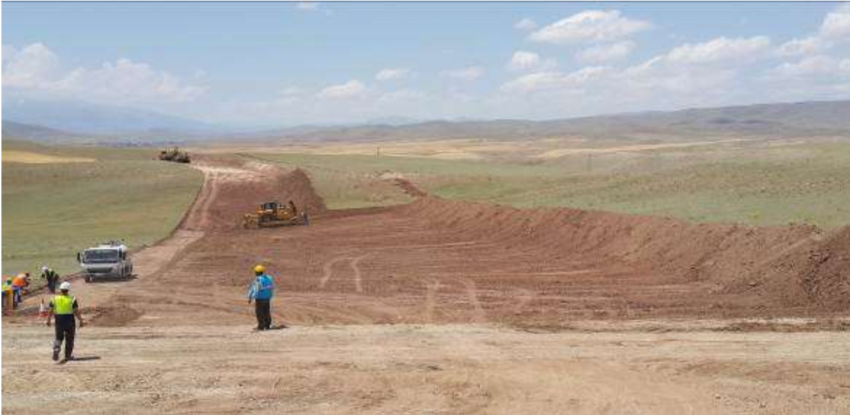
Şekil III.2.19.60. İnşaat Döneminde Bitkisel (Üst) Toprağın Sıyırılması Çalışmaları, Fotoğraflar: B. ERDEM, 2005 / 2015
