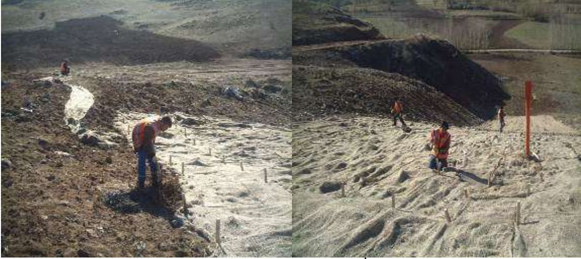
Şekil III.2.19.86. Tahta Çubukların Dağıtılması ve Alana Çakılması İşlemleri, Fotoğraflar: B. ERDEM, 2006
