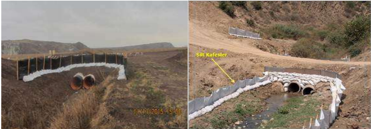
Şekil III.2.19.74. Sedimentasyon Kontrolünde Silt Kafes Uygulaması, Fotoğraflar: B. ERDEM, 2006 / 2015
