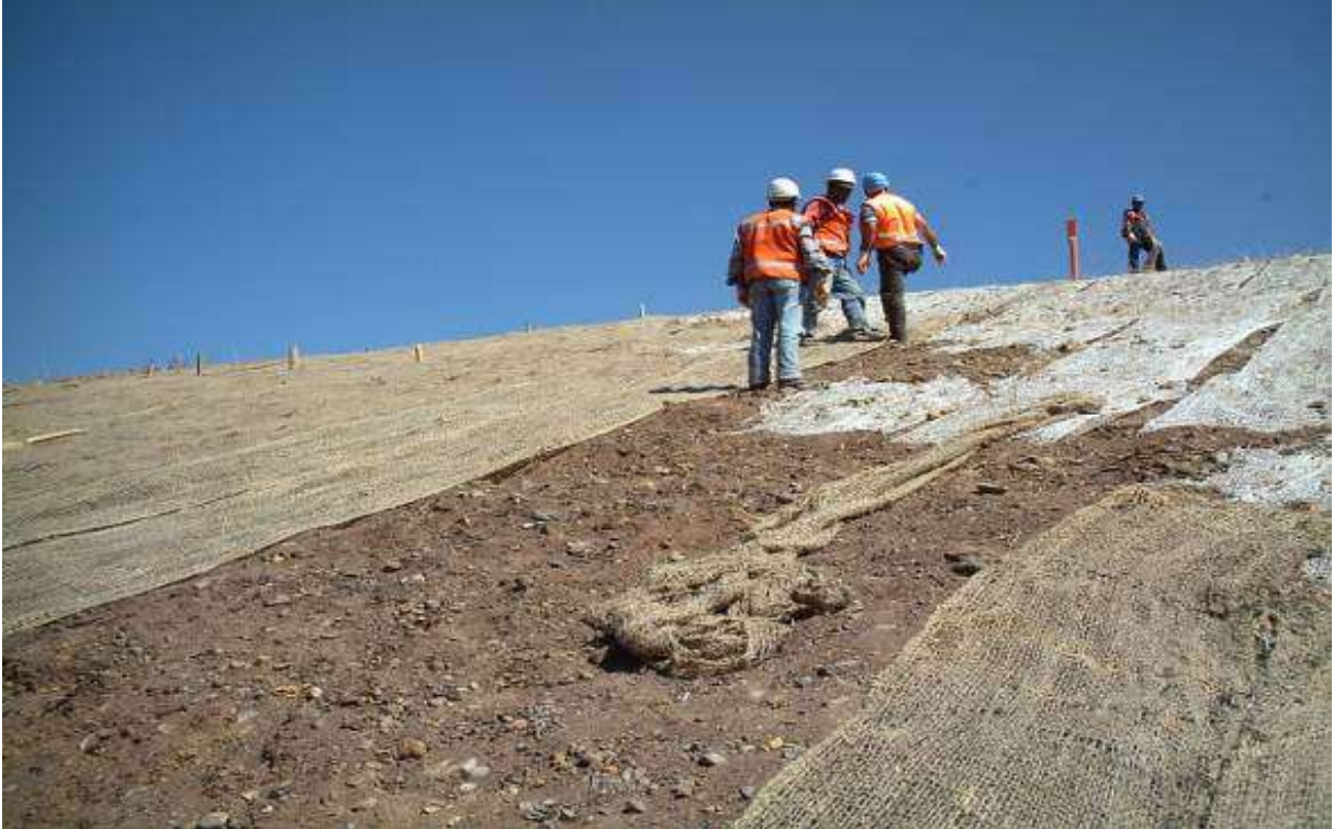
Şekil III.2.19.114 Jüt Hasırı Uygulamasında Meydana Gelen Hasarların Onarımı, Fotoğraf: B. ERDEM, 2006
