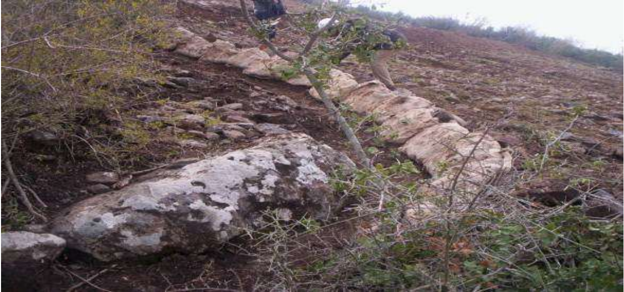
Şekil III.2.19.89. Kalıcı Erozyon Kontrol Önlemleri, Saptırma Banketleri, Fotoğraf: B. ERDEM, 2005
