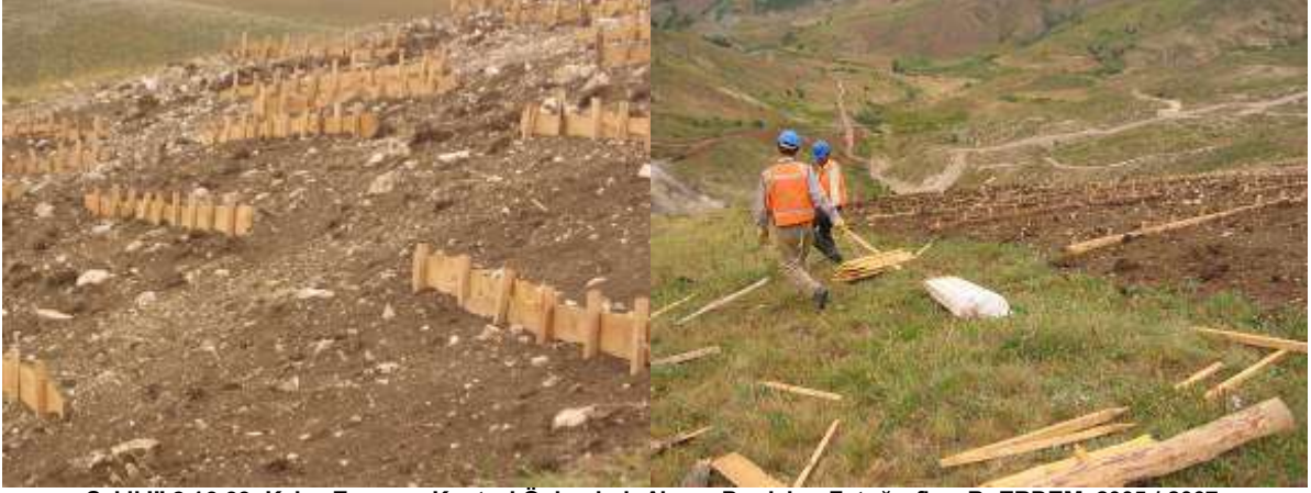
Şekil III.2.19.93. Kalıcı Erozyon Kontrol Önlemleri, Ahşap Perdeler, Fotoğraflar: B. ERDEM, 2005 / 2007
