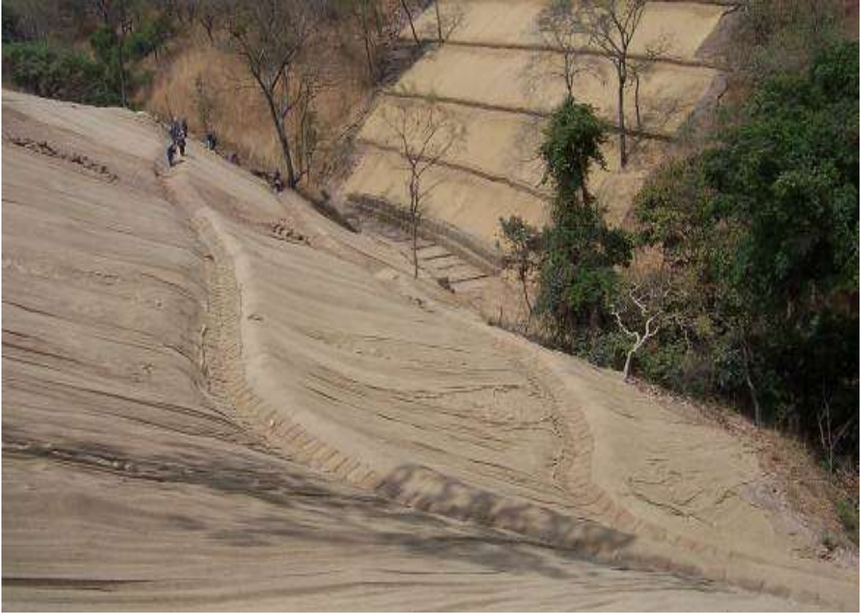
Şekil III.2.19.55. Jüt Hasırı Uygulanması, Fotoğraflar: B. ERDEM, 2005 / 2006
