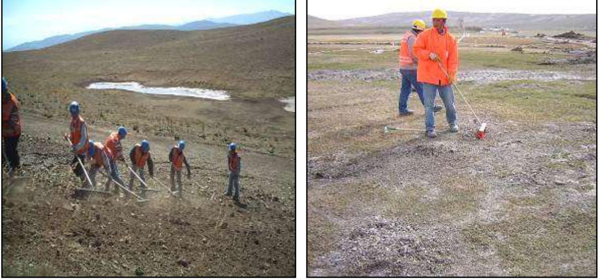
Şekil III.2.19.103. Tohum Atılması Sonrasında Yapılan Tırmıklama ve Süpürge Uygulaması, Fotoğraflar: B. ERDEM, 2005
