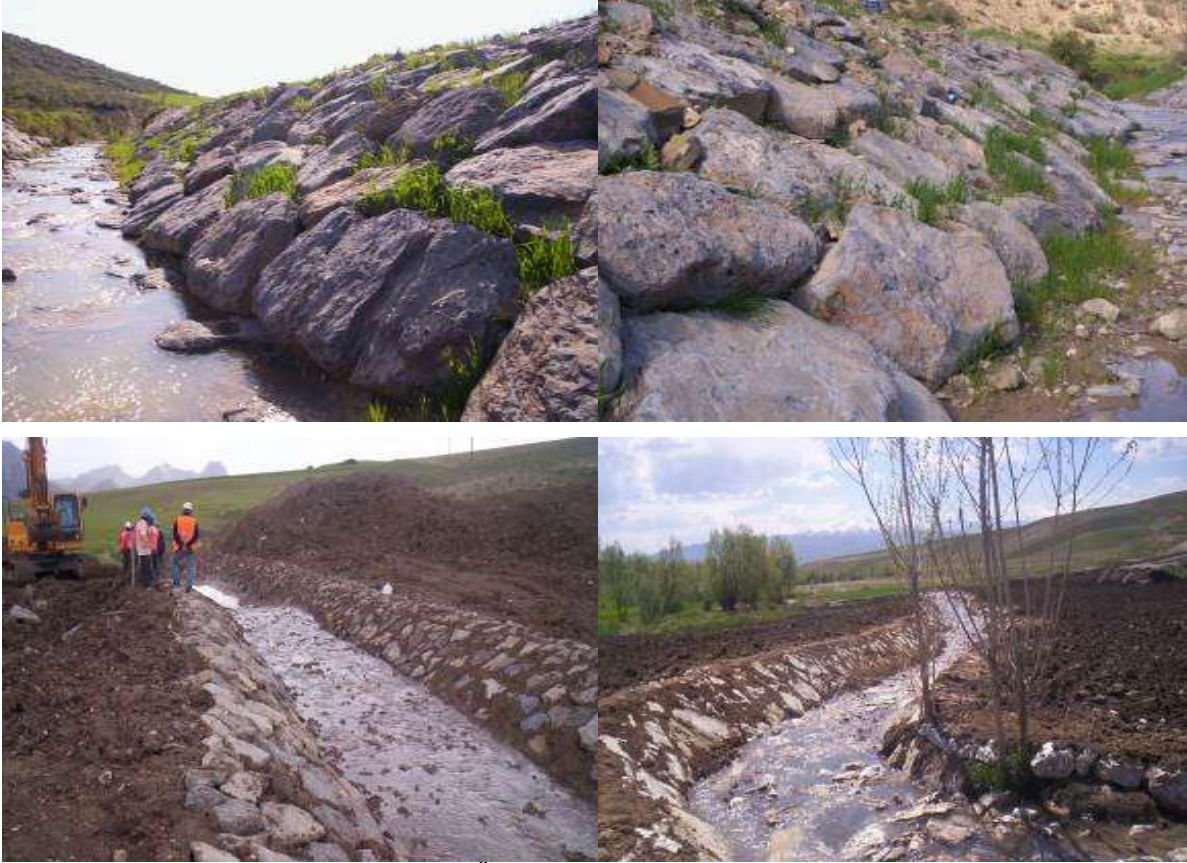
Şekil III.2.19.91. Kalıcı Erozyon Kontrol Önlemleri, Rip-rap Yapıları, Fotoğraflar: B. ERDEM, 2005 / 2007
