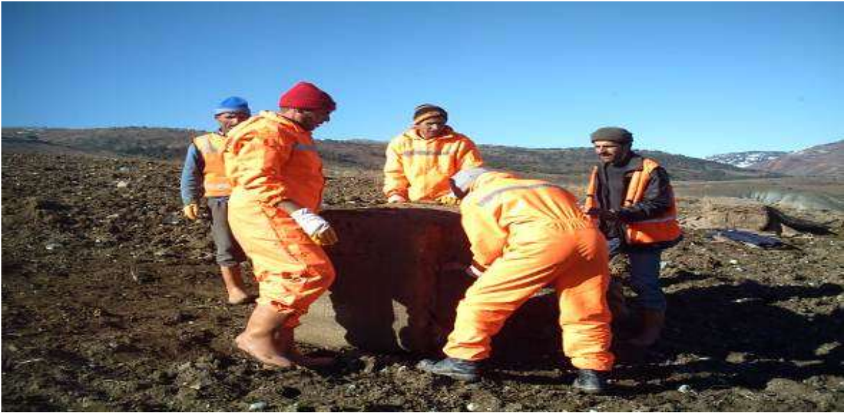
Şekil III.2.19.83. Jüt Hasırı Balyalarının Açılması, Fotoğraf: B. ERDEM, 2006
