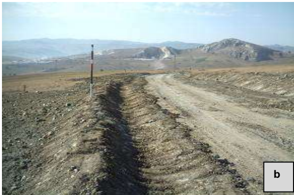
Şekil III.2.19.71. a, b ve c- Dikine ve Enine Eğimlerde Açılan Drenaj Kanalları, Eğim Kırıcılar, Fotoğraflar: B. ERDEM, 2006
