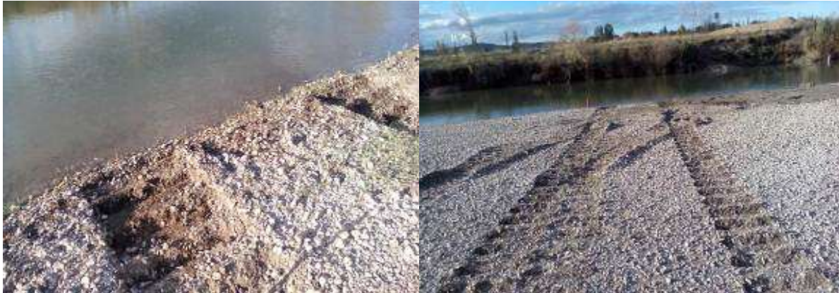
Şekil III.2.19.76. Sedimentasyon Kontrolünde Uygun Olmayan Dere Geçişleri, Fotoğraflar: B. ERDEM, 2015
