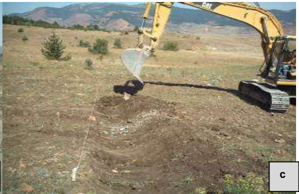
Şekil III.2.19.71. a, b ve c- Dikine ve Enine Eğimlerde Açılan Drenaj Kanalları, Eğim Kırıcılar, Fotoğraflar: B. ERDEM, 2006
