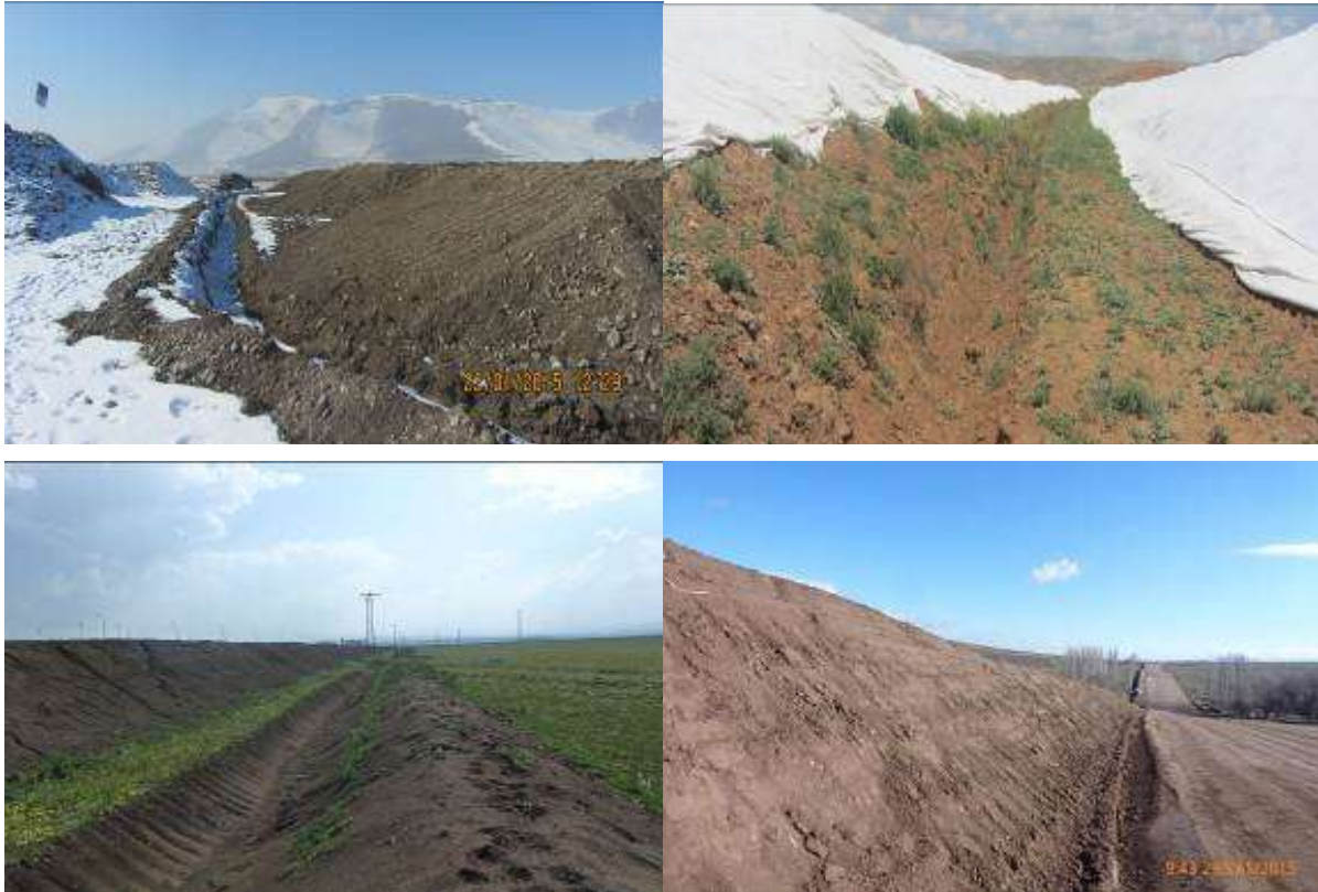
Şekil III.2.19.65. Üst Toprak Depolama Alanlarında Açılan Drenaj Kanalları, Fotoğraflar: B. ERDEM, 2015
