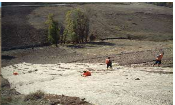
Şekil III.2.19.72. Erozyon Şiltesi ve Jüt Hasırı Uygulaması Fotoğraflar: B. ERDEM, 2006
