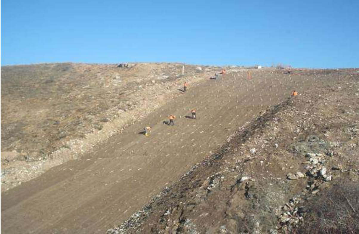
Şekil III.2.19.85. Serilen Jüt hasır Parçalarının Alana Sabitlenmesi, Fotoğraf: B. ERDEM, 2006
