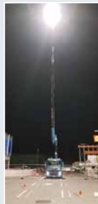
Ausleuchtung eines Parkplatzes aus großer Höhe.
