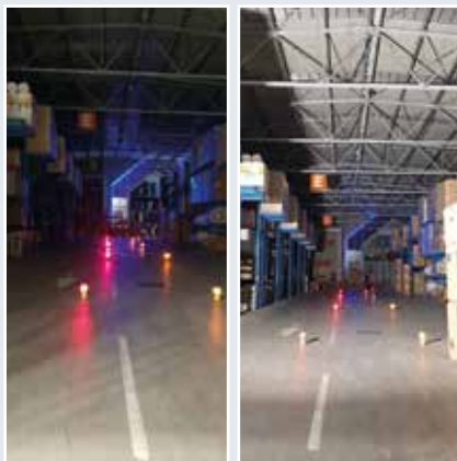
Ausleuchtung einer Lagerhalle mit einem Energyline Großflächenstrahler. Bild links: Strahler ist aus. Bild rechts: Strahler ist eingeschaltet.
