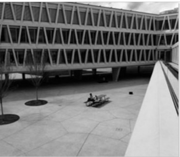
Auch das Gebäude ist schon ein Kunstwerk: Innenhof der DSM
