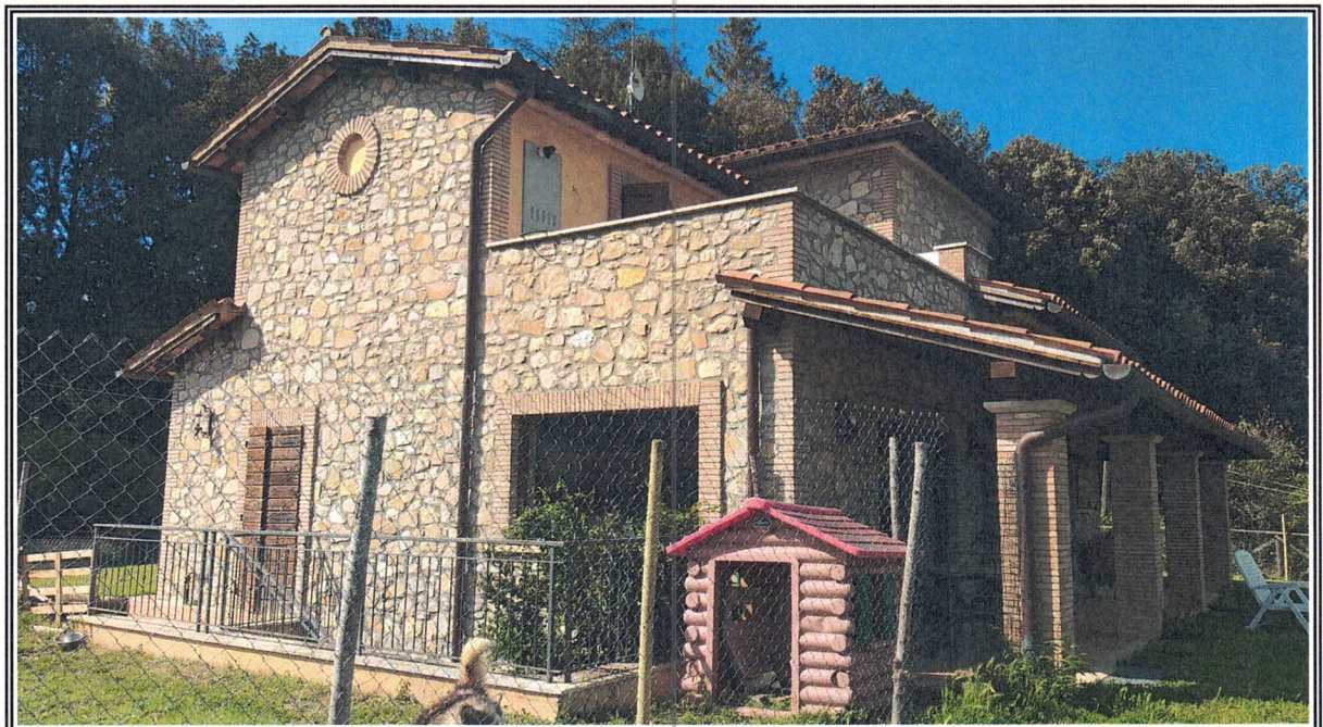
FOTO ESTERNA FABBRICATO PROSPETTO SUD-EST
