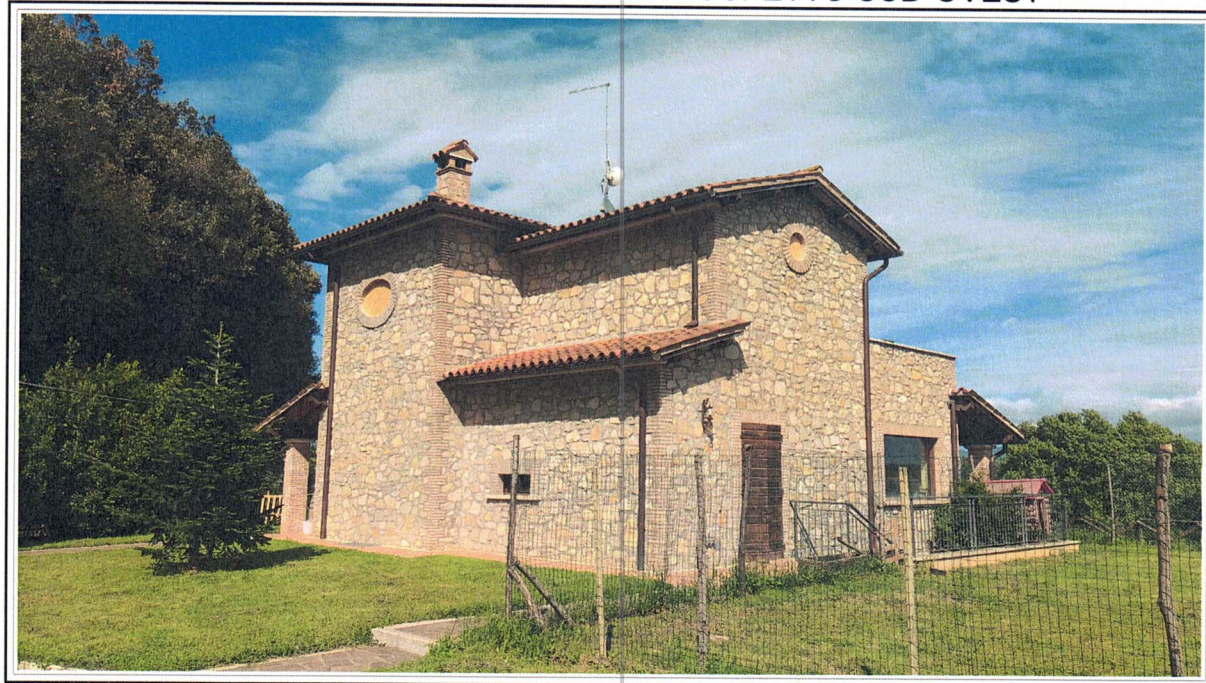
FOTO ESTERNA FABBRICATO PROSPETTO SUD-OVEST
