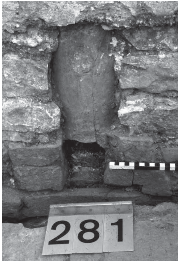
Abb. 79: Augst/BL, Insula 36 (Grabung 1984.051). Detailansicht des in Mauer MR 3603.Eb.04 integrierten Heissluftrohrs. Ansicht von Westen.
