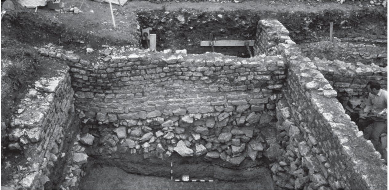
Abb. 45: Augst/BL, Insula 36 (Grabung 1984.051). Mauer MR 3602.D-E.01, Nordseite, darunter das Fundament von MR 3602.C.02. Rechts: MR 3601.D-E.03, links MR 3603.Eb.02. Ansicht von Norden.
