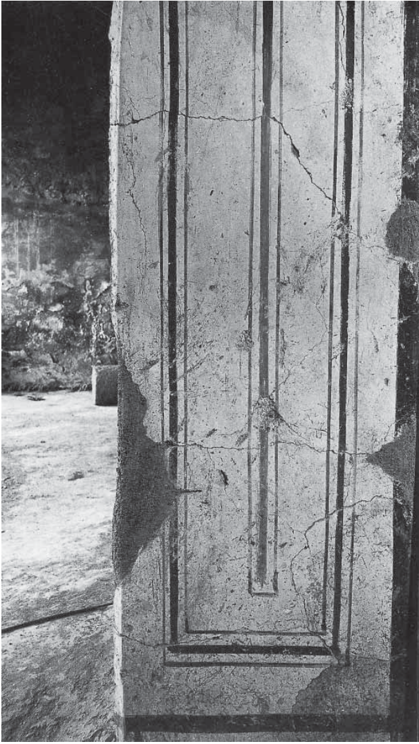
Fig. 126: Pompéi (I). Pilastre du cubiculum 8 de la boulangerie de Sotericus (I 12, 1-2).
