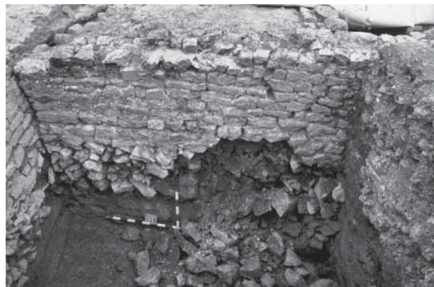
Abb. 44: Augst/BL, Insula 36 (Grabung 1984.051). Mauer MR 3602.D–E.01, Südseite. Links MR 3601.D–E.03. Deutlich erkennbar ist die Stossfuge zwischen den Mauern. Ansicht von Süden.
