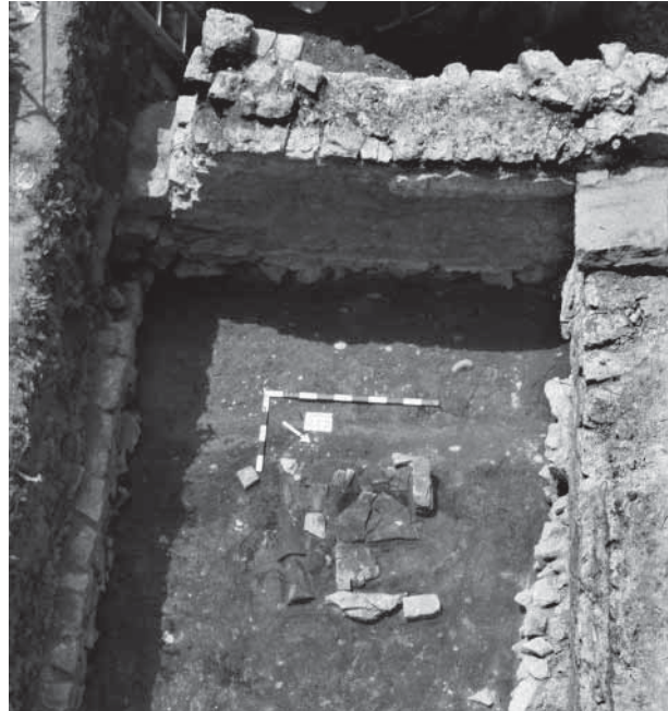
Abb. 27: Augst/BL, Insula 36 (Grabung 1984.051). Balkengraben zu Holzwand HW 3601.Cc.01.02 und Feuerstelle Fst 3601.Cc.01.06. Oben MR 3601.Eb.04, rechts MR 3601.Eb.02 mit der zerbrochenen Schwelle von Tür 3601.Eb.01. Ansicht von Osten.
