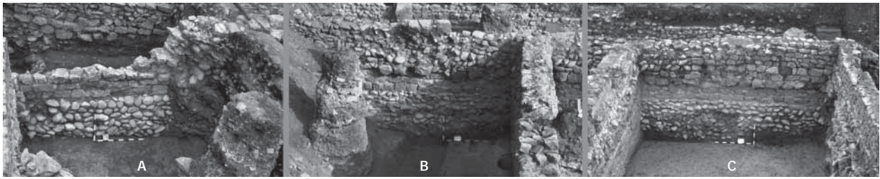
Abb. 23: Augst/BL, Insula 36 (Grabung 1984.051). Nördliche Aussenmauer von Gebäude 3601 in den Bauzuständen MR 3601.C.01 bis MR 3601.E.01, Südseite. – A: westlichster, teilweise zerstörter Teil. – B: westlicher Teil beim Anschluss an MR 3601.Eb.04 (rechts), links Messpunkt E'9. – C: östlicher Teil zwischen MR 3601.Eb.04 (links) und MR 3601.D-E.03 (rechts). Ansicht von Süden.
