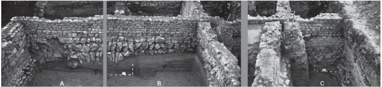
Abb. 34: Augst/BL, Insula 36 (Grabung 1984.051). Östliche Aussenmauer von Gebäude 3601 in den Bauzuständen D-E: MR 3601.D-E.03, Westseite. – A: nördlicher Teil mit Anschluss an MR 3601.C-E.01. – B: an A anschliessender mittlerer Teil mit anstossender Mauer MR 3601.Eb.02 (rechts) und MR 3602.D-E.01 im Hintergrund. – C: südlicher Teil zwischen MR 3601.C-D.02 (rechts) und MR 3601.Eb.02 (links); in der Ecke links Messpunkt J'10. Ansicht von Westen.
