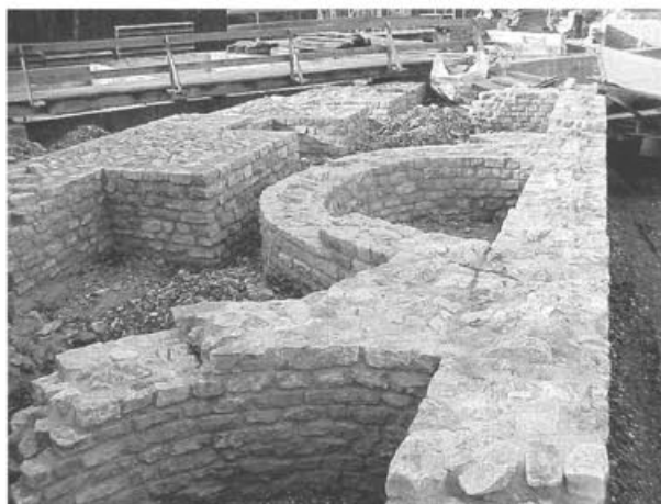
Abb. 1: Augst, neu erworbenes Ruinengelände beim Werkhof der Firma E. Frey AG (Grabung 1997.60/1998.60/1999.60). Die fertig konservierte, jüngere Hangstützmauer 3 (vgl. Abb. 40). Links im Hintergrund ist die ältere Stützmauer mit den Strebepeilern erkennbar. Das römische Bad und das unterirdische, überwölbte Brunnenhaus liegen rechts ausserhalb des Bildausschnittes (vgl. unten, Abb. 38–42).
