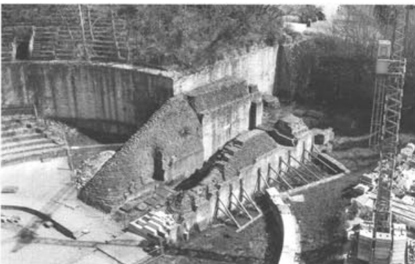
Abb. 30: Augst, Theatersanierung (Grabung 1999.55). Blick auf die Südwestecke des Theaters mit Zustand vor den Restaurierungsarbeiten. Im Hintergrund ist die Caveaabschlussmauer-Süd mit dem Pflanzenbewuchs auf Keil 4 zu sehen.
