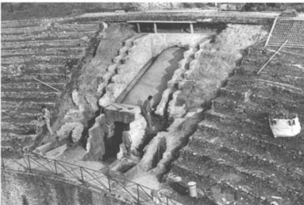
Abb. 36: Augst, Theatersanierung (Grabung 1999.55). Westteil des Südostvomitatoriums (Abb. 1,B), Betongewölbe, während den Freilegungsarbeiten.
