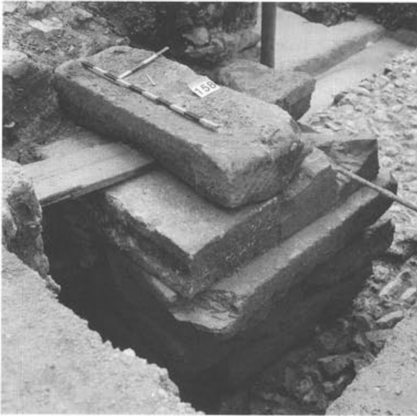
Abb. 9: Kaiseraugst AG, Lützelschwab, Dorfstrasse 74/Kastellstrasse (Grabung 1972.02). Blick von Norden auf die Nordostecke des «reduzierten Südtors» des Castrum Rauracense.
