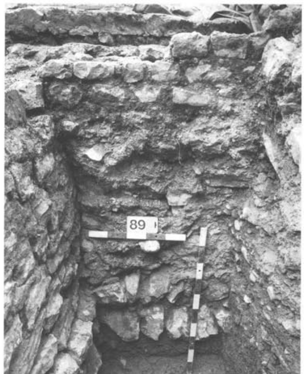
Abb. 7: Augst, Theatersanierung (Grabung 1999.55). Nördliche Flügelmauern des Ersten Theaters. Ansicht an Mauer 17/315. Im unteren Bereich die aus fischgrätartig versetzten Kalkbruchsteinen bestehende Mauer 315 (Phase B). Darüber das massive, stark mörtelhaltige Fundament von Mauer 17 (1. Theater).
