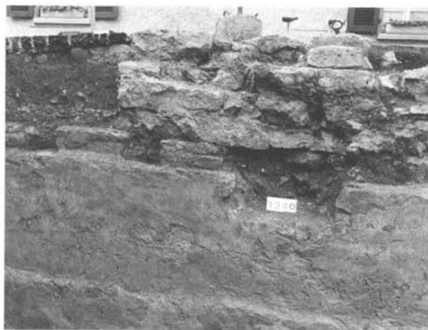
Abb. 12: Kaiseraugst, «Adler» (Grabung 1990.05). Blick von Osten an die verputzte Kellermauer 28 mit Aussparungen für die Deckenbalken und der (vermuteten) Fensteröffnung (bei der Fotonummer). Über den Balkenaussparungen liegt das Fundament des abgerissenen Ökonomiegebäudes.
