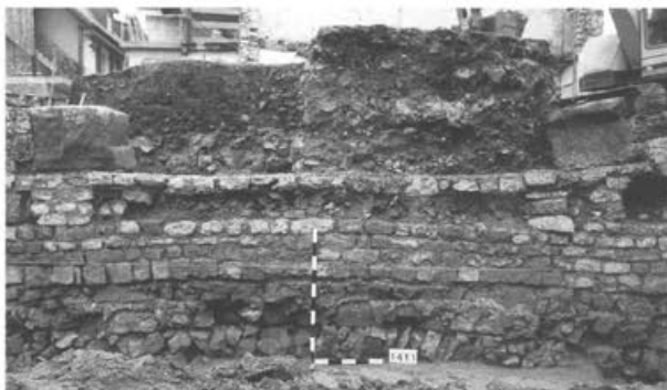
Abb. 16: Kaiseraugst, «Adler» (Grabung 1990.05). Blick von Westen auf die Tordurchfahrt in Mauer 7/11 (Bauphase C4). Auf den erhaltenen vier Steinlagen der älteren Phase der Mauer 7/11 liegt eine schuttige (Ausgleichs-) Schicht, auf welche eine Quaderlage als Schwellenunterzug verlegt ist. Die Durchfahrt wird beidseitig von je einem Buntsandsteinquader, vermutlich die Basen des Torgewändes, flankiert. Im Profil hinter der Tordurchfahrt zeichnen sich die Mauerschuttsschicht der Bauphase D5 (Schicht D5.603) und die (nach-)römische Deckschicht ab.
