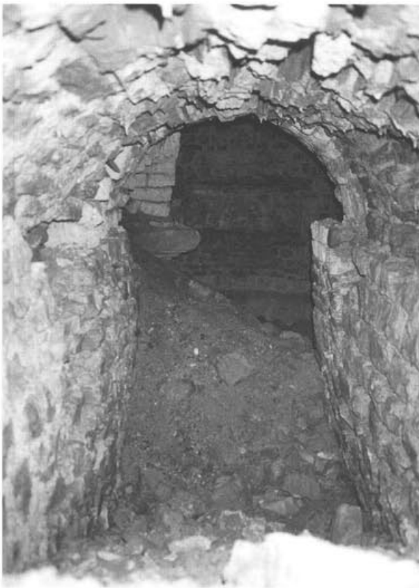
Abb. 7: Augst BL, E. Frey AG (Grabung 1999.60). Blick vom Scheitel des Schuttkegels unter der Einbruchstelle des Tunnels in das Gewölbe. Gut erkennbar ist im Mittelgrund der Schuttkegel, der sich von links aus dem Brunnenschacht in das Gewölbe hinein erstreckt. Von Osten.
