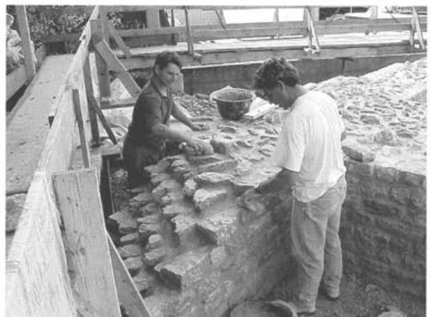
Abb. 41: Augst, E. Frey AG (Grabung 1997.60/1998.60/1999.60). Avelino und Antonio de Matos Cruz beim Konservieren der älteren Hangstützmauer 16 (Abb. 1; 38; 39, links). Rechts ist einer der Strebepfeiler erkennbar (MR 24).
