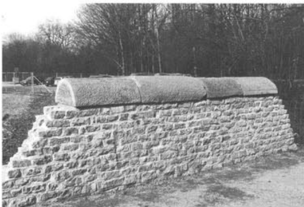
Abb. 43: Augst, Osttorareal (Grabung 1998.56). Dieser Mauerabschnitt (MR 1) veranschaulicht heute die einstige Umfassung des monumentalen Grabrundbaus vor dem Osttor von Augusta Raurica. Die Teilrekonstruktion ist in der vermuteten Brüstungshöhe ausgeführt. Von den vier halbzyllindrischen Abdecksteinen aus Buntsandstein sind die mittleren beiden Originale, zum Schutz flankiert von zwei nachgeahenen Elementen (von Ost).
