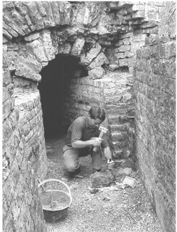
Abb. 44: Augst, Forum/Treppenhaus und Basilika-Stützmauer Nord (Grabung 1910.60). Avelino de Matos Cruz bei Ausbesserungs- und Reparaturarbeiten in der Kloake, welche das Forum unterirdisch entwässerte. Sie wurden nötig, nachdem sich Steine von den beiden Kloakenwänden gelöst und die Besucher gefährdet hatten.
