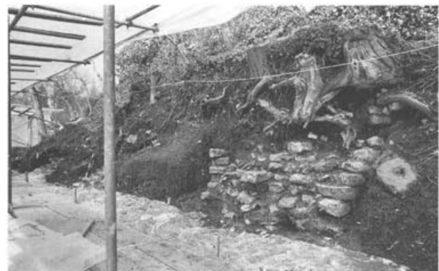
Abb. 31: Augst, Theatersanierung (Grabung 1999.55). Mauerkrone der Caveaabschlussmauer-Süd. Blick auf die freigelegte Böschung mit den Wurzelstöcken der abgesägten Akazien unmittelbar oberhalb des Originalmauerwerks der Entlastungsbogen.
