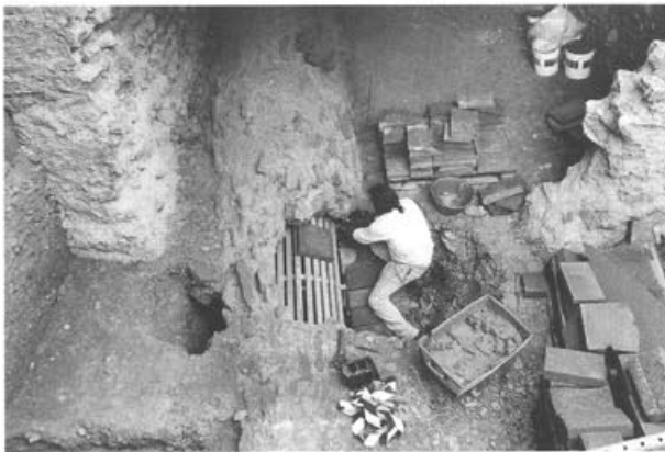
Abb. 42: Augst, E. Frey AG (Grabung 1997.60/1998.60/1999.60). Steinmetz Gregor Bucher beim Ergänzen des teilweise eingebrochenen Tunnelgewölbes (Zugangsrampe zum unterirdischen «Brunnenhaus»; Abb. 38,C).
