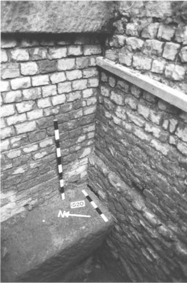
Abb. 29: Augst, Theatersanierung (Grabung 1999.55). Sondierung an Stützpfiler MR 194 (Abb. 1,3). Stossfuge zwischen dem Stützpfiler (links) und der Umfassungsmauer des Älteren szenischen Theaters (rechts). Der Stützpfiler weist auch in den Fundamenten in regelmässigem Abstand von ca. 1,80 m durchschliessende Gurte aus Buntsandstein auf.
