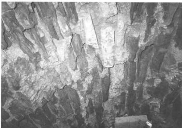
Abb. 11: Augst BL, E. Frey AG (Grabung 1999.60). Blick an die Innenseite der Tunneldecke. Im Westteil der Tunneldecke wurden als Schlusssteine des Gewölbes Tuffstein-Platten eingefügt (in Bildmitte). Blick von Westen gegen den Tunnelausgang.
