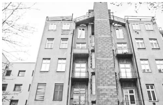
Alles Zonen: Ballsportzone, Hundezone – Mensch und Tier sicher verwahrt im Drahtverhau (Bild oben und Mitte) Unten Prolozone, oben Penthousezone: Das Dach saniert, der Aufzug kommt, Bestand an Altmieten aufgelöst (Bild unten)
