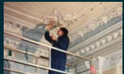
1994 – Anke Wendl bei der Freilegung der Stuckvergoldung im Saal
