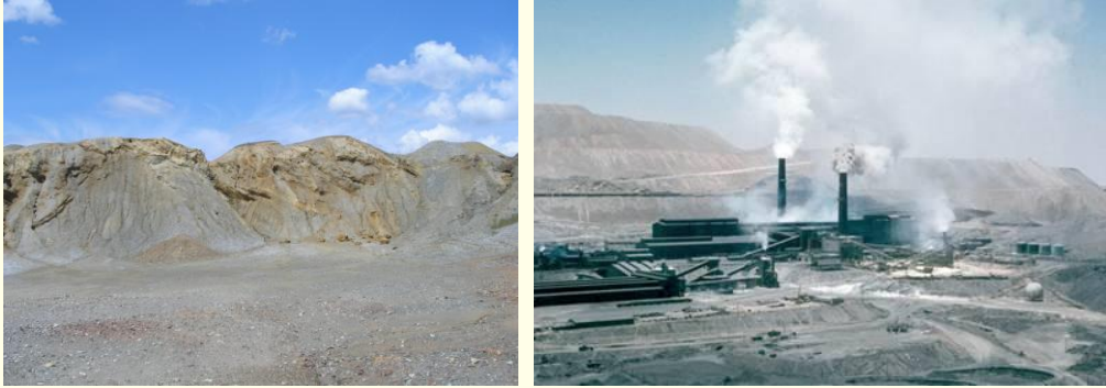
Izquierda, antigua balsa en San Quintín Este desde donde se desprende dióxido de azufre. A la derecha se puede observar la fundición de cobre de Chuquicamata (Chile) en el año 1984, cuando las chimeneas enviaban a la atmósfera toneladas de SO 2 .
