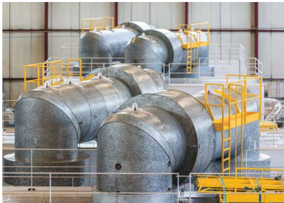
Beznau NPP powerhouse
