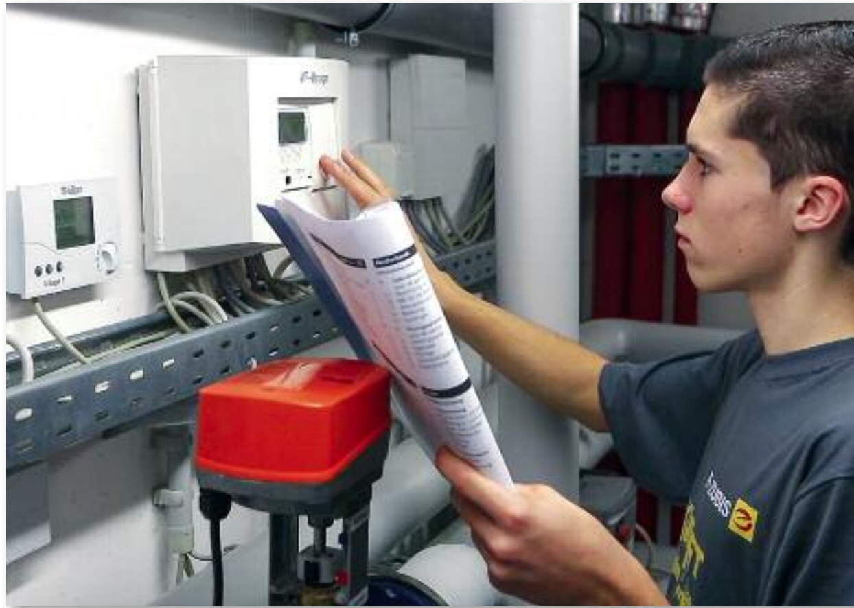
Interessante Branche mit sehr guter Perspektive: Die Berufe im Elektrohandwerk erfreuen sich einer stark wachsenden Beliebtheit. Hier konfiguriert ein „E-Zubi“ einen Wärmepumpen-Manager.
