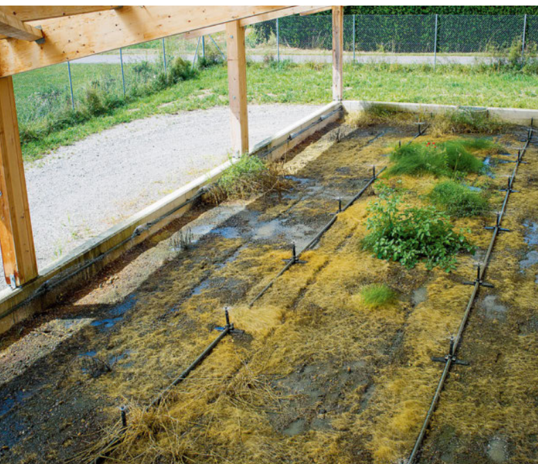
Die Wasserqualität des Ruisseau des Charmilles bei Genf (Bild rechts) hat sich stark verbessert, seit mit Pflanzenschutzmitteln verunreinigtes Spülwasser aufgefangen und biologisch gereinigt wird. Nach dem Reinigen der Spritzgeräte wird das Abwasser über einem mit Kompost, Stroh und Erde gefüllten Becken (auch als Biobac bezeichnet) versprüht (Bilder links und Mitte).
