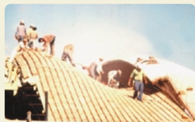
POSA DEI LATERIZI
