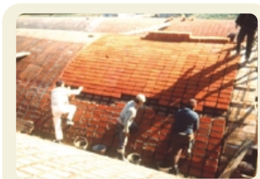
COMPLETAMENTO DELLA VOLTA
