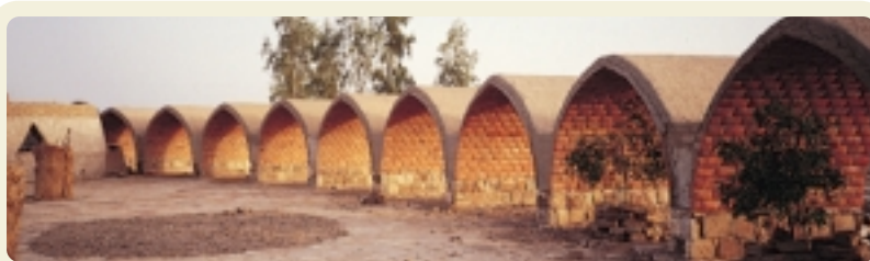
FABRIZIO CARÒLA, CENTRO DI FORMAZIONE E RICERCA PER LE TECNOLOGIE DI COSTRUZIONE PER IL SAHEL (MALI)
