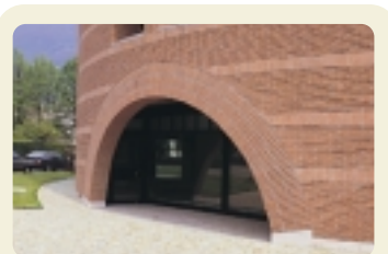
MARIO BOTTA, TORRE A LUGANO (CH)
