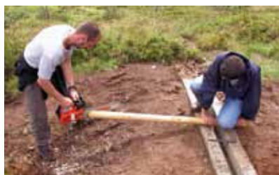
Pose d'une voie d'eau pour limiter l'érosion des sentiers.
