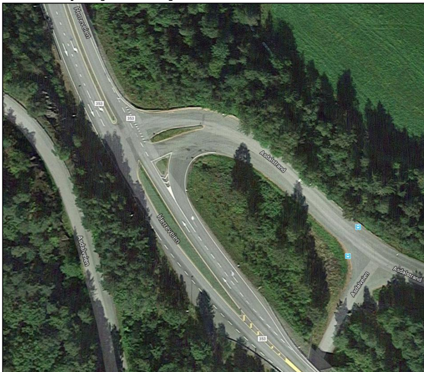
Figur 2-3: Kanalisert kryss mellom fv. 353 og avkjøring til Rønningen industriområde. 65 meter langt venstresvingefelt fra nord. Høyresvingende avkjøringsrampe fra sør. Gang-/sykkelveg fra krysset Asdalsveien x Asdalstrand og innover mot industriområdet på Rønningen. (google.com/maps, 21.02.2019)
