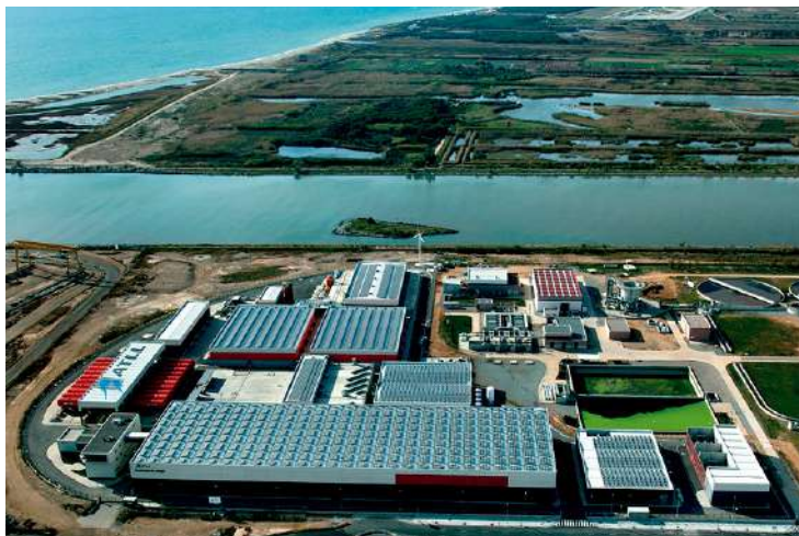
▲ Vista aèria de la dessalinitzadora del Prat de Llobregat.
